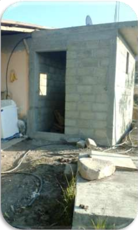
Construcción de Cuarto para Baño
