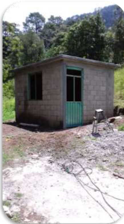
Construcción de Cuarto para Cocina
