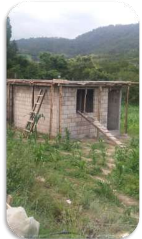
Construcción de Cuarto Dormitorio
