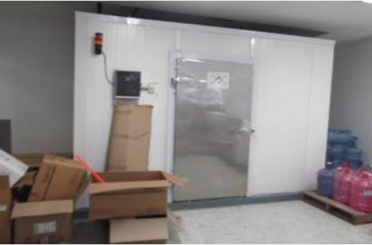
Se instaló en el Almacén de reactivos una cámara fría.
