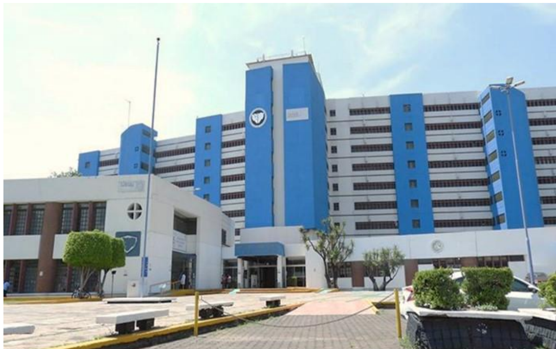
Fachada del Hospital Psiquiátrico Fray Bernardino Álvarez
