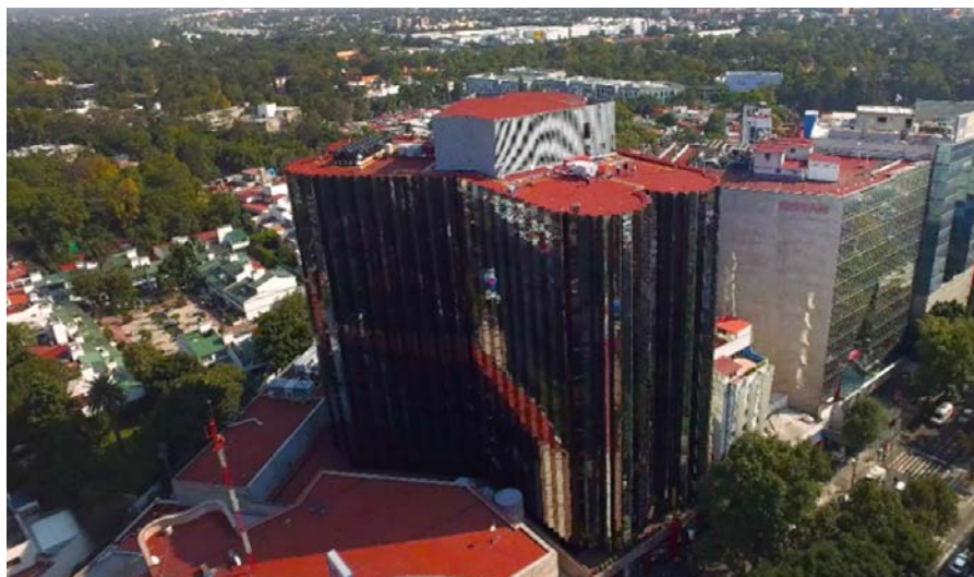
Figura 59. Inmueble de SE
