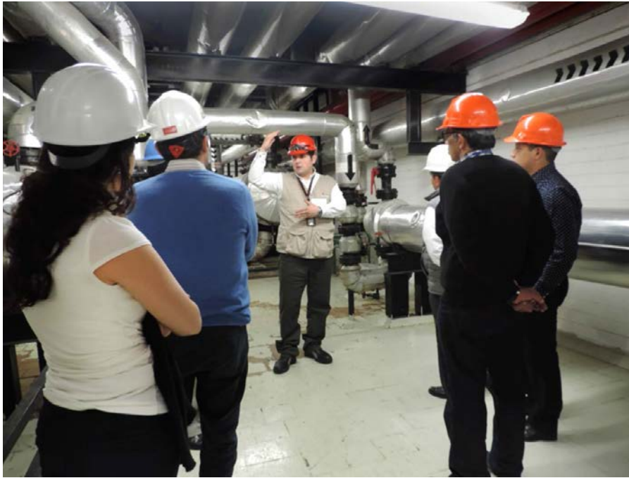
Figura 8. Visita técnica a la Torre Ejecutiva de PEMEX
