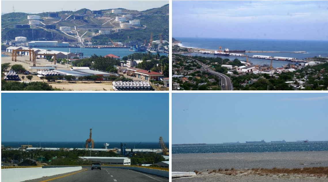
Figura 1.9 Infraestructura Multimodal en la ZEE y la ZEEF Elaboró: Social Value Institute
