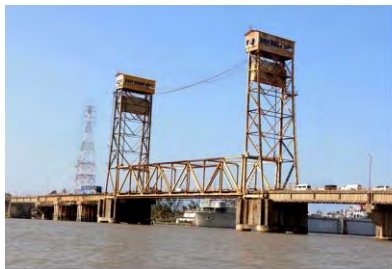
Puente Coatzacoalcos I
