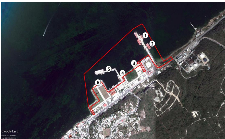
Ilustración 5. Infraestructura portuaria existente en el puerto de Lerma
