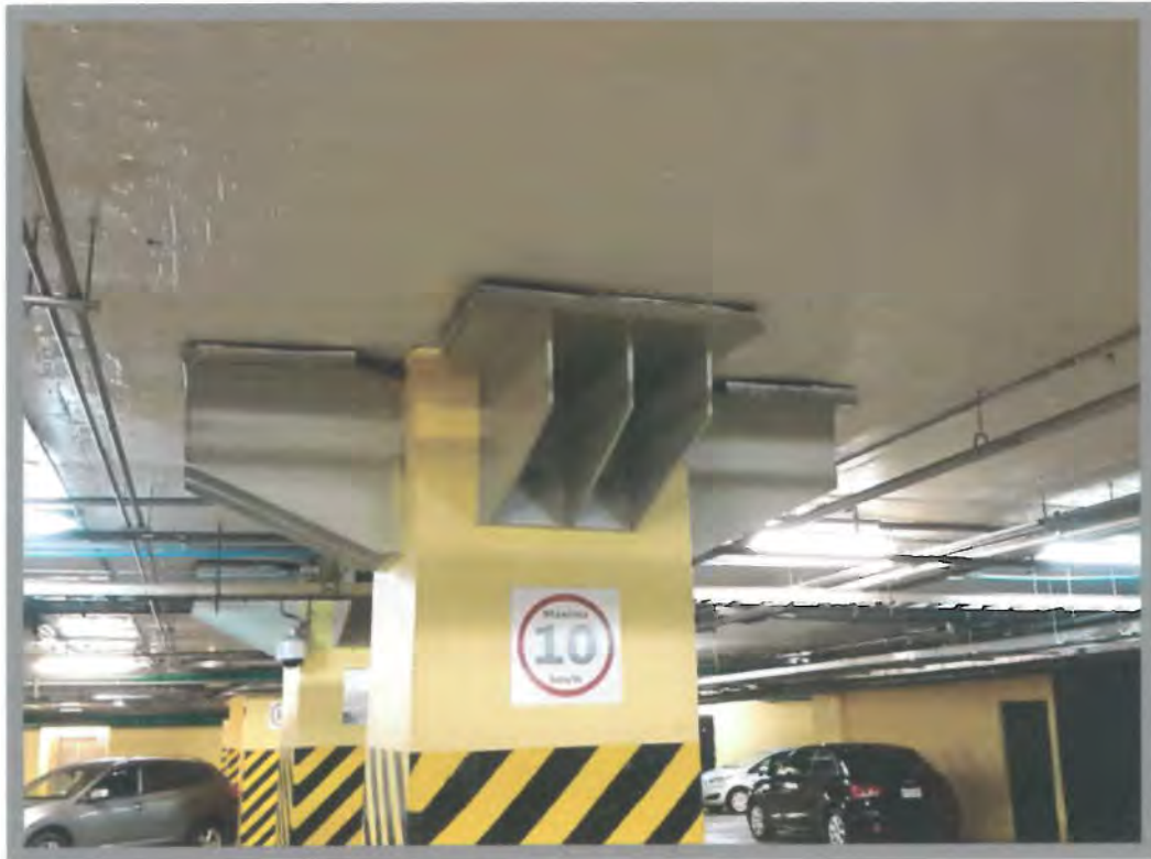
Foto 16 Refuerzo de capitel en losas planas de sótanos
