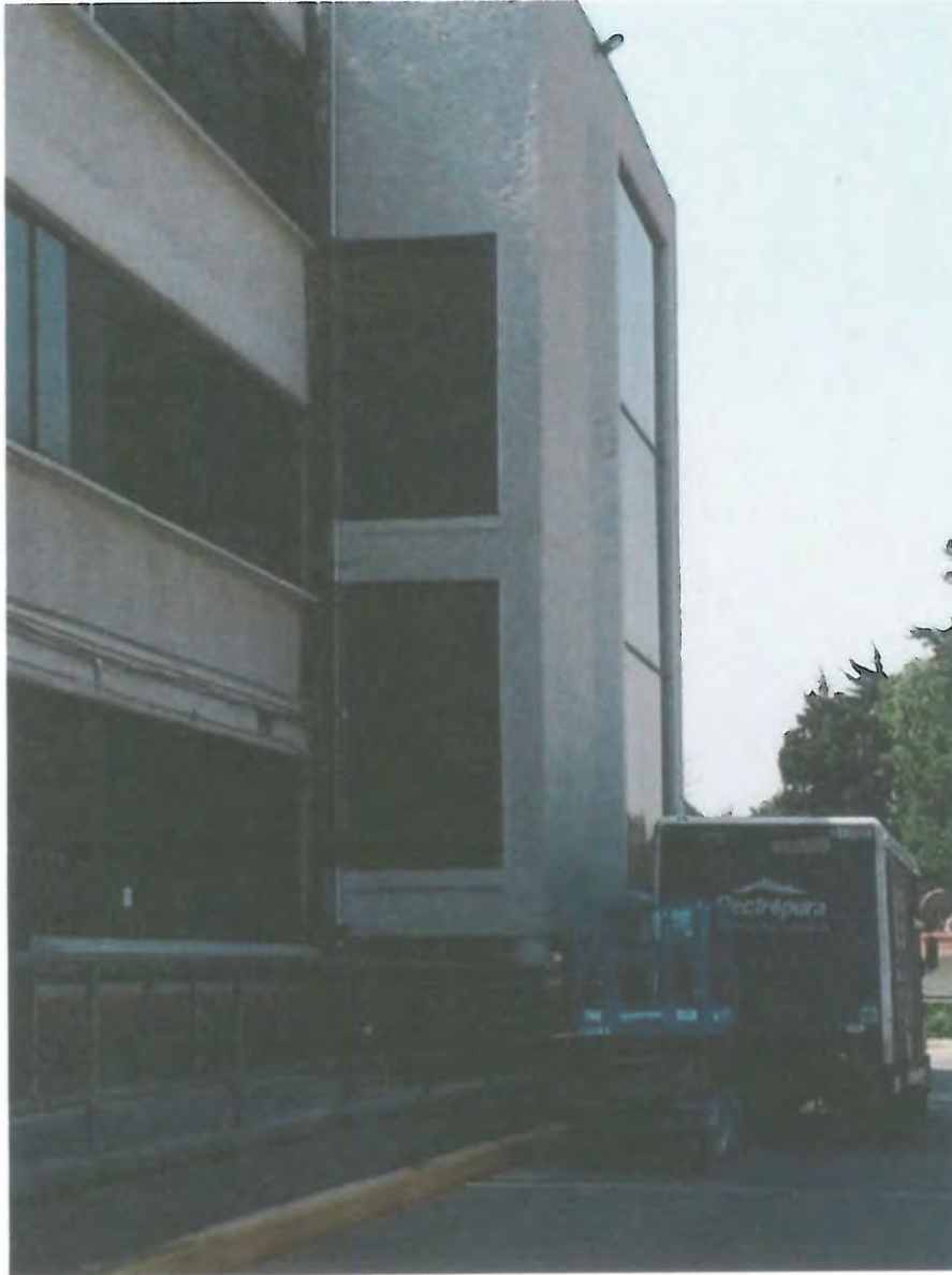
EDIFICIO DE OFICINA SIN DAÑOS
