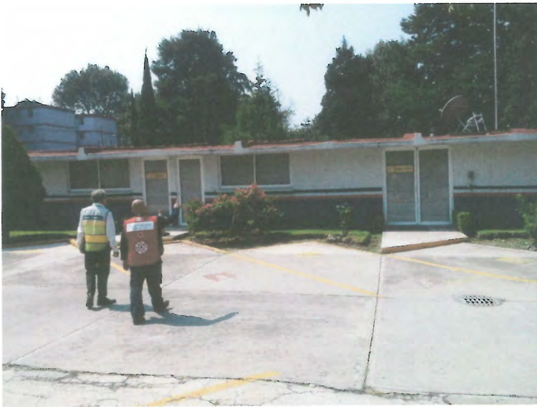
AULAS DE CAPACITACION SIN DAÑOS
