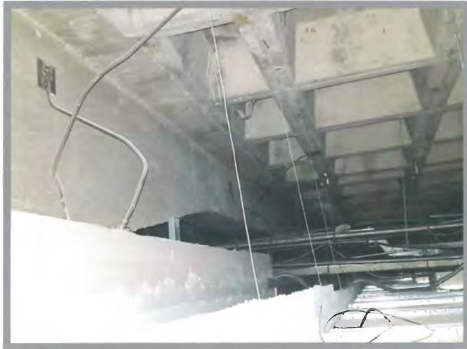
Foto 10 Sistema de traves acarteladas con losa reticular en Módulo 4
