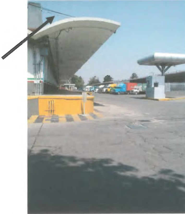
FOTO 01.- MANTENIMIENTO A TENSORES DE LOSAS
