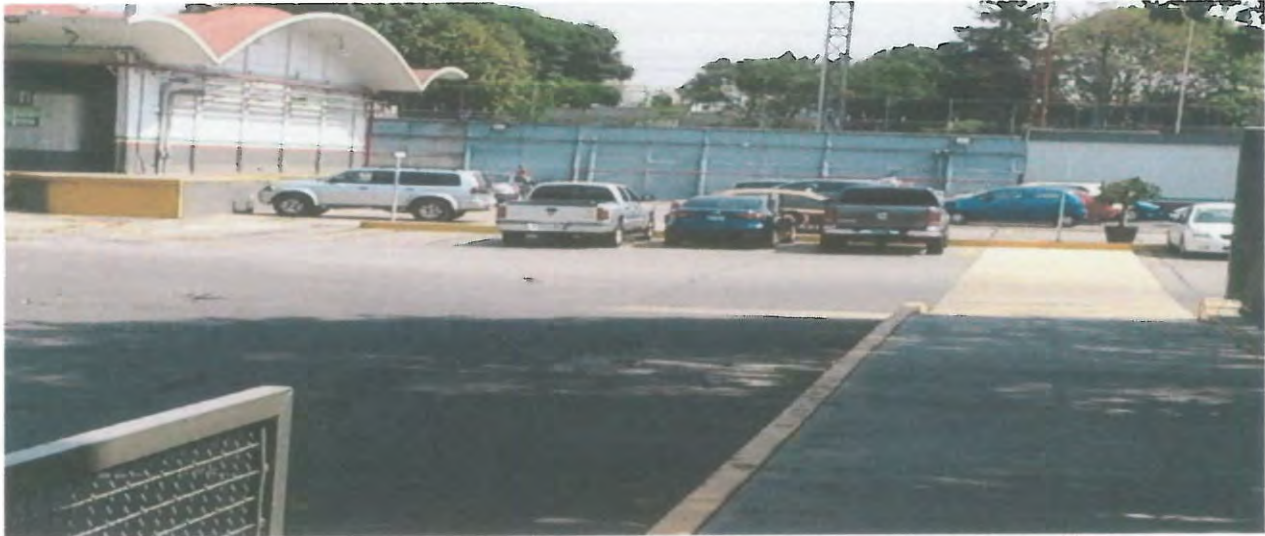
AREA DEL ESTACIONAMIENTO, EN ACCESO, SIN DAÑOS.
