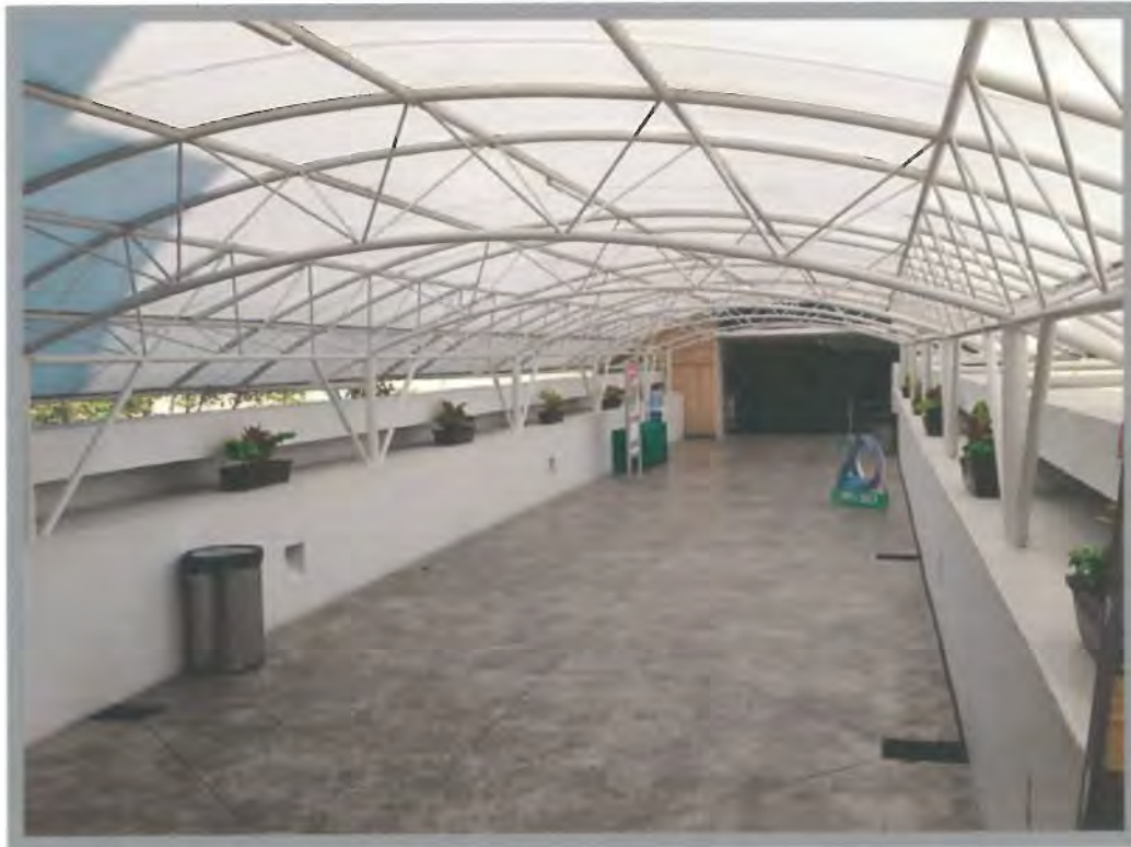
Foto 6 Puente peatonal que cruza la calle de Valerio Trujano. Es recomendable revisar a detalle los apoyos en ambos extremos
