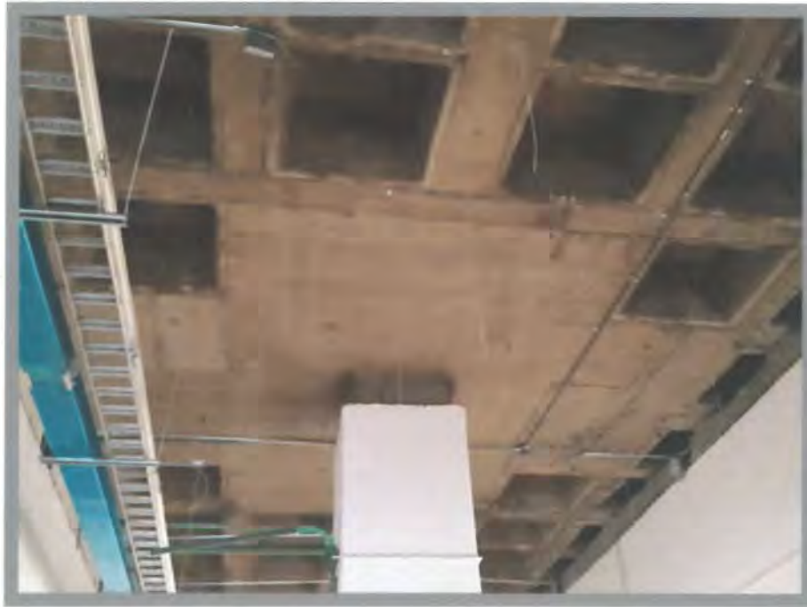
Foto 12 Unión capitel con columna sin daño. Sistema de losa plana
