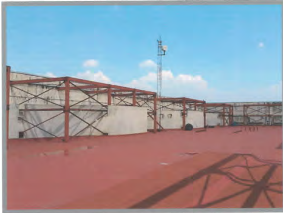
Foto 7 Azoteas del Conjunto Hidalgo sin sobrecargas extraordinarias
