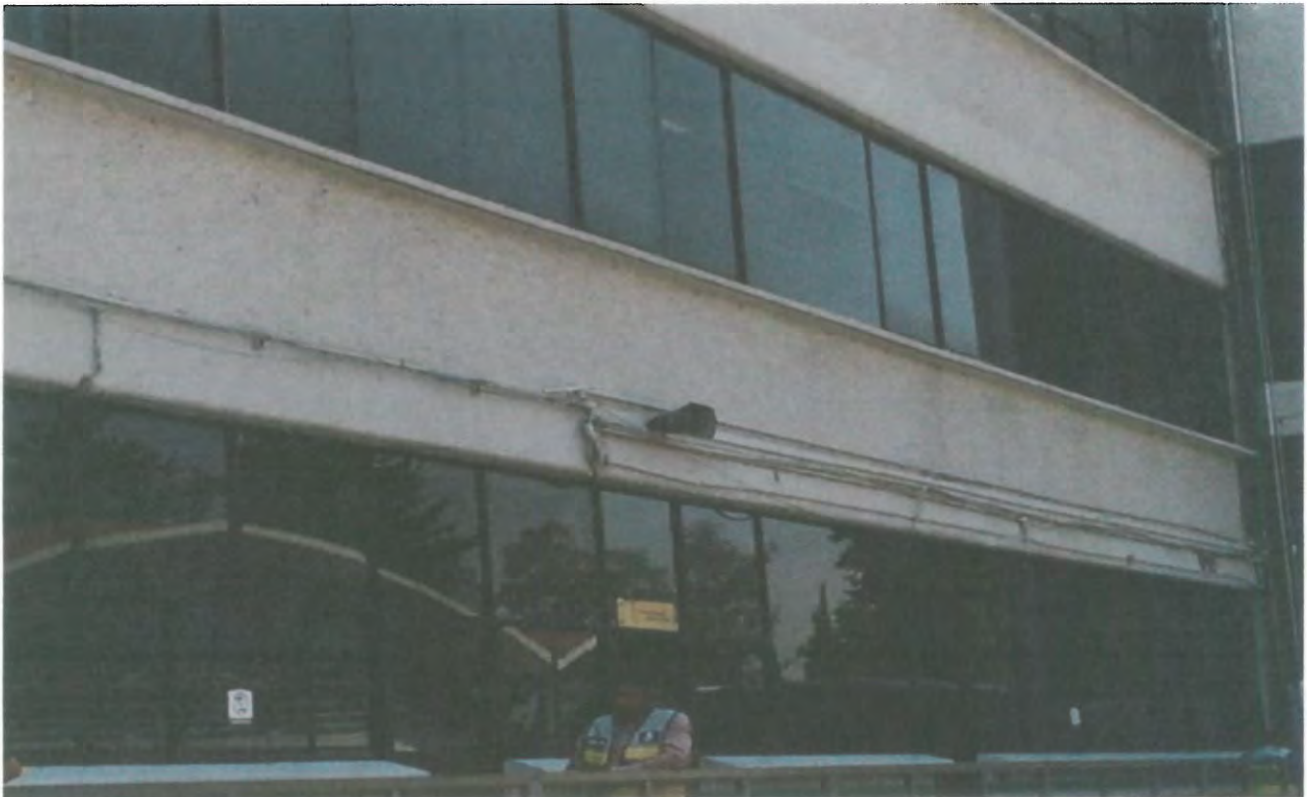
FACHADA DE EDIFICIO DE OFICINAS SIN DAÑOS
