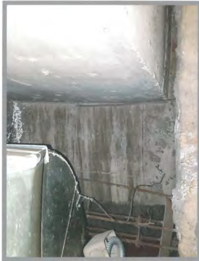
Foto 9 Unión trabe acartelada con columnas sin daños en Módulo 4
