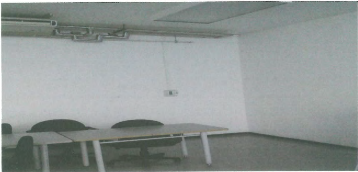
MUROS SIN DAÑOS EN OFICINAS
