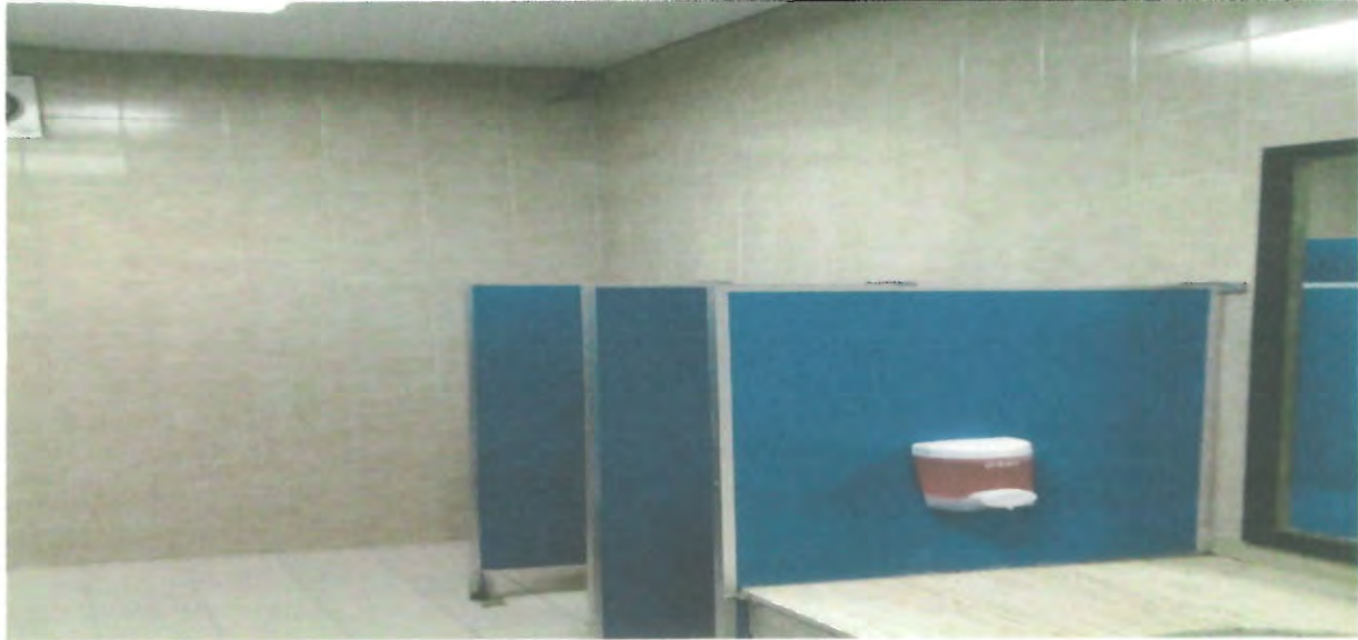
SANITARIOS SIN DAÑOS
