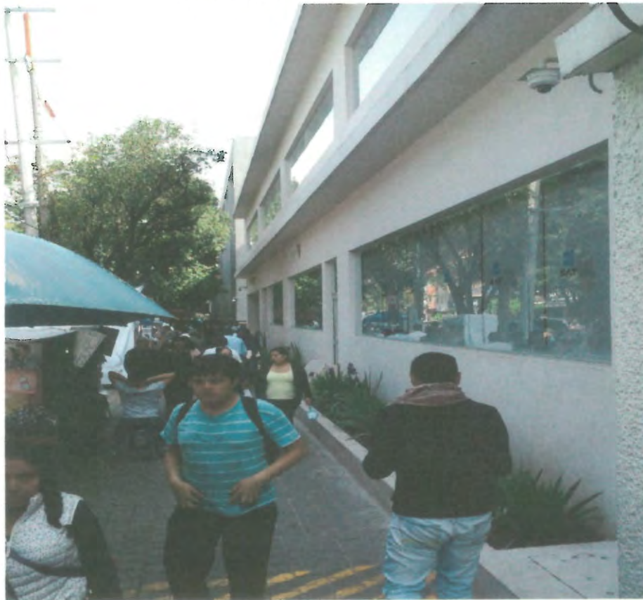
FACHADA SIN DAÑOS
