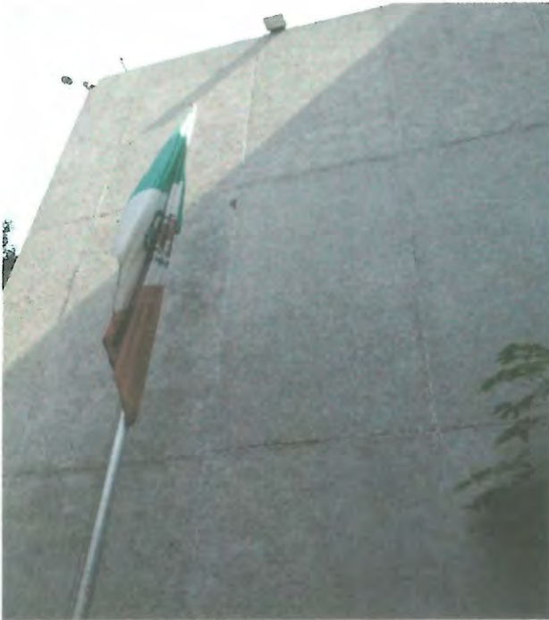
FACHADA LATERAL SIN DAÑOS
