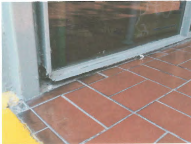
FOTOS 06.- MANTENIMIENTO A CANCELERIA DE FIERRO
