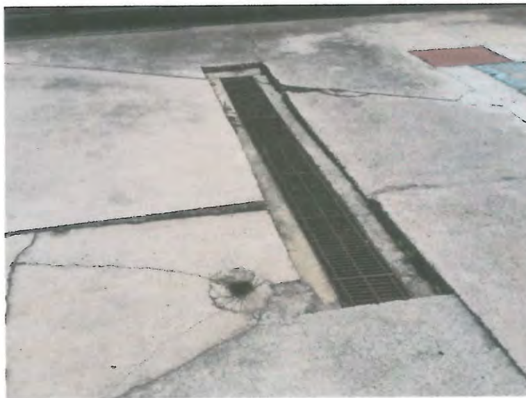
FOTO 05.- REPARACION DE PAVIMENTO Y REGISTROS
