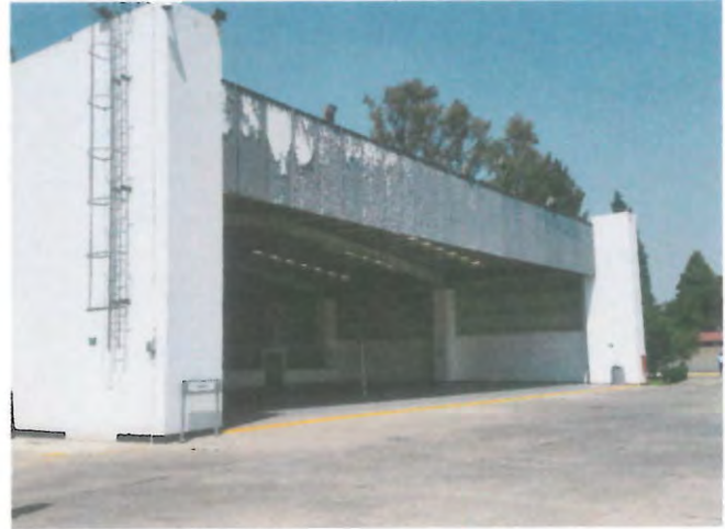
FACHADA DE GIMNASIO
