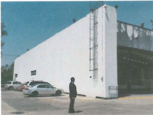
FACHADA DE GIMNASIO
