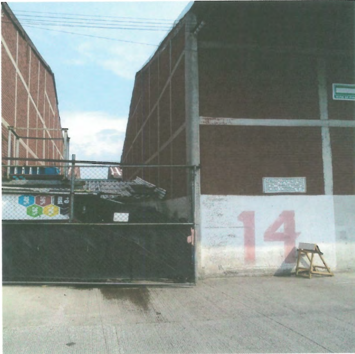
FACHADA SIN DAÑOS
