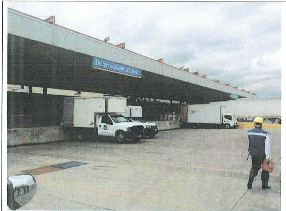
Foto 7. Cubierta de plataforma de importación, no presenta fallas.
