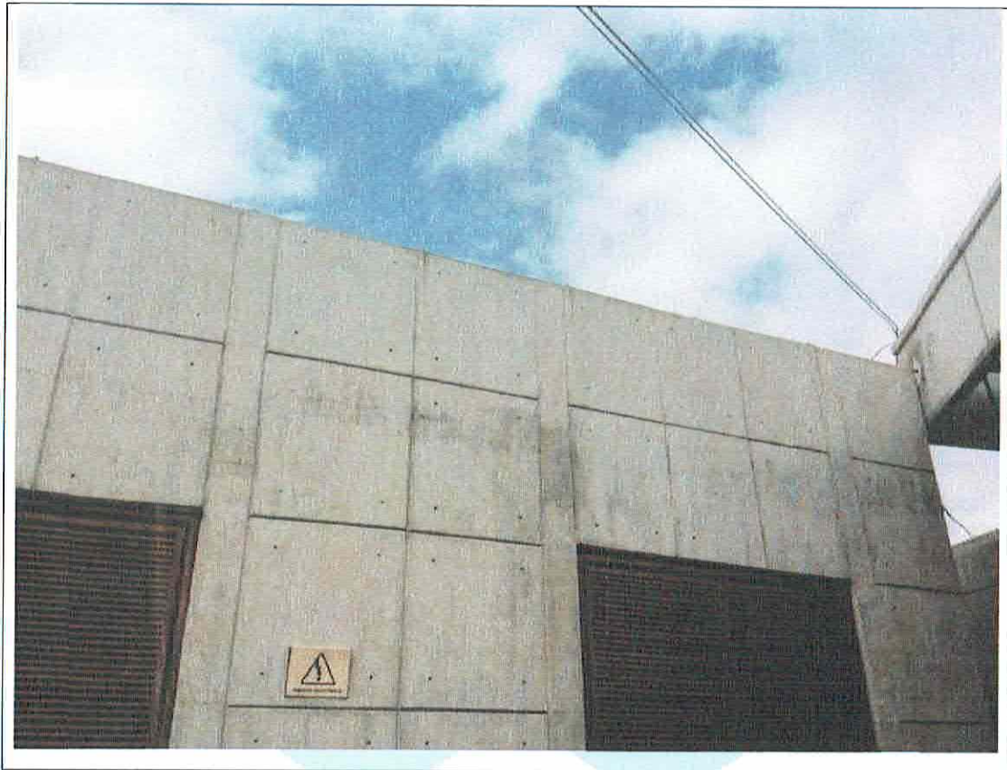
Foto 20. Estructuras se encuentran en buenas condiciones estructurales después del evento del pasado 19 de Septiembre.
