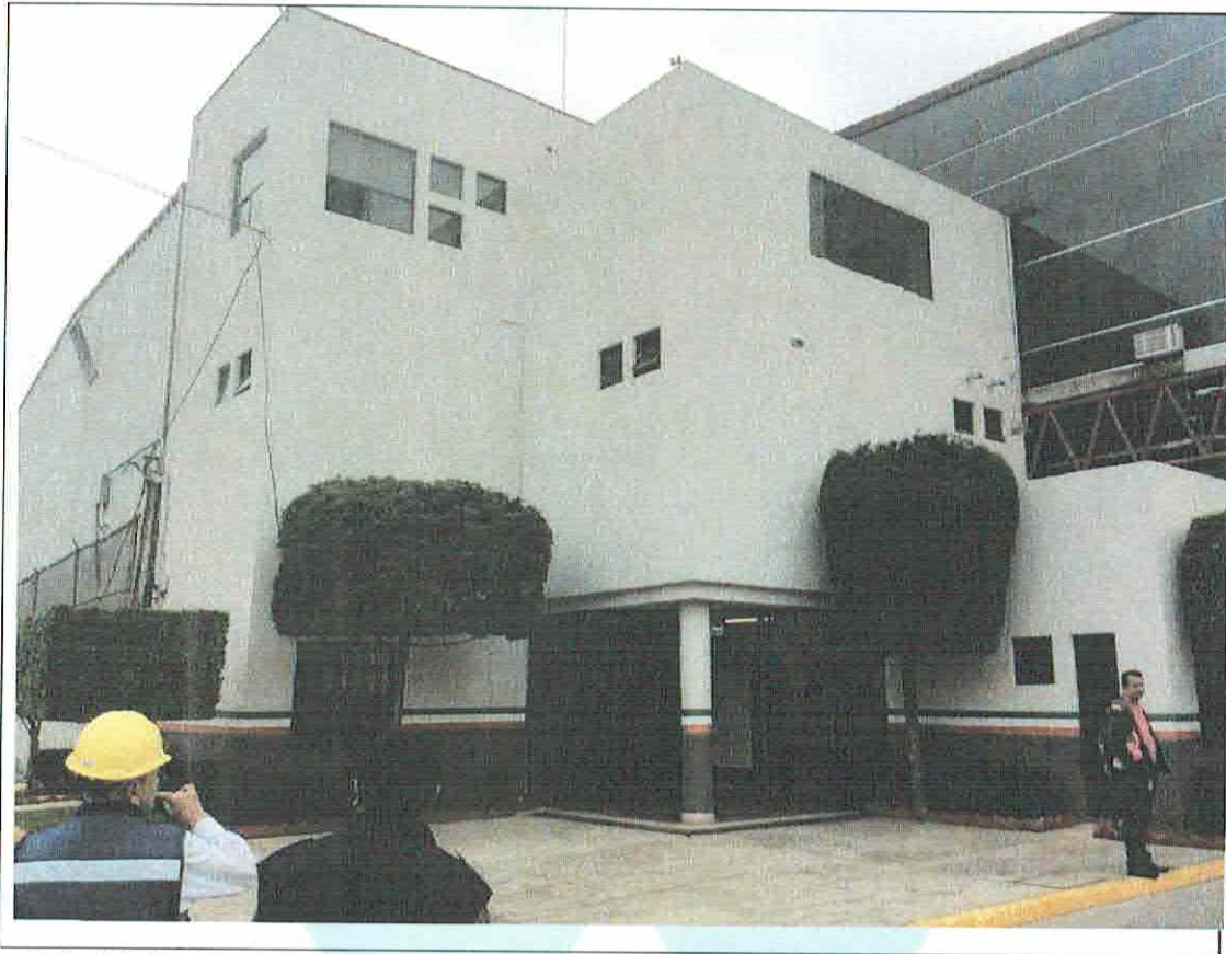
Foto 24. Dado o mocheta donde se desplanta columna de la estructura principal de bodegas.
