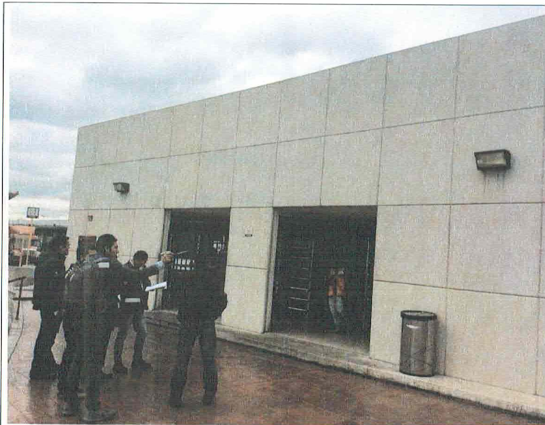
Foto 21. Estructuras se encuentran en buenas condiciones estructurales después del evento del pasado 19 de Septiembre.
