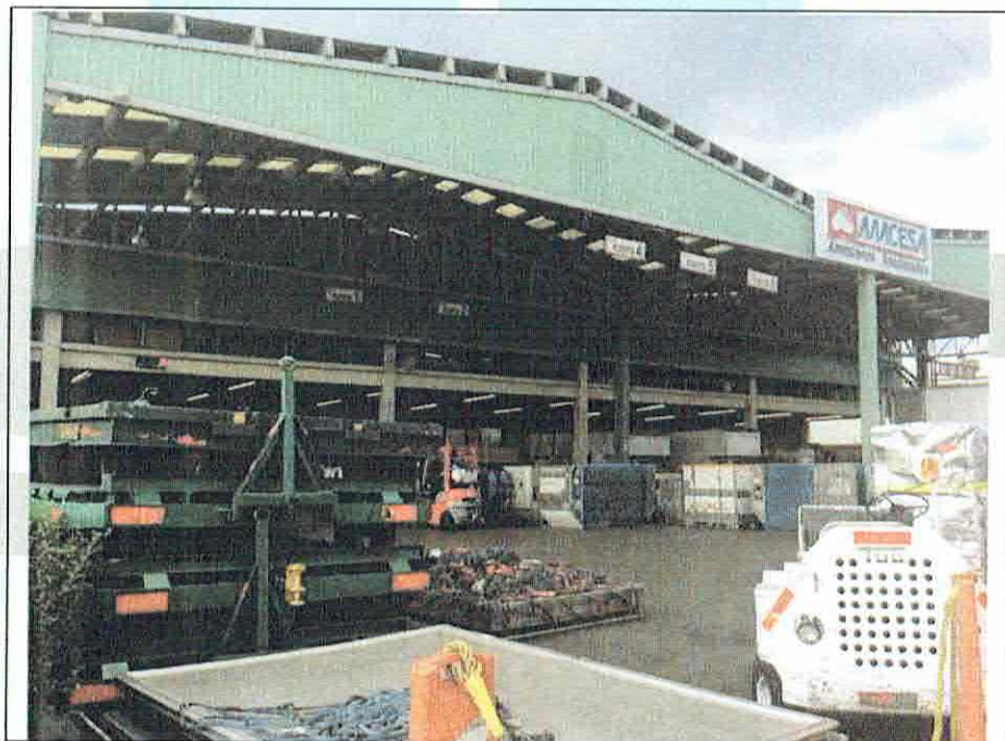
Foto 2. Cubierta exterior de una nave en el recinto fiscal, no presenta fallas.
