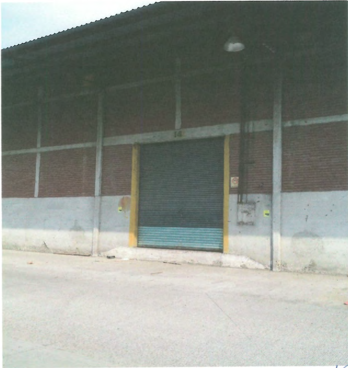
FACHADA SIN DAÑOS
