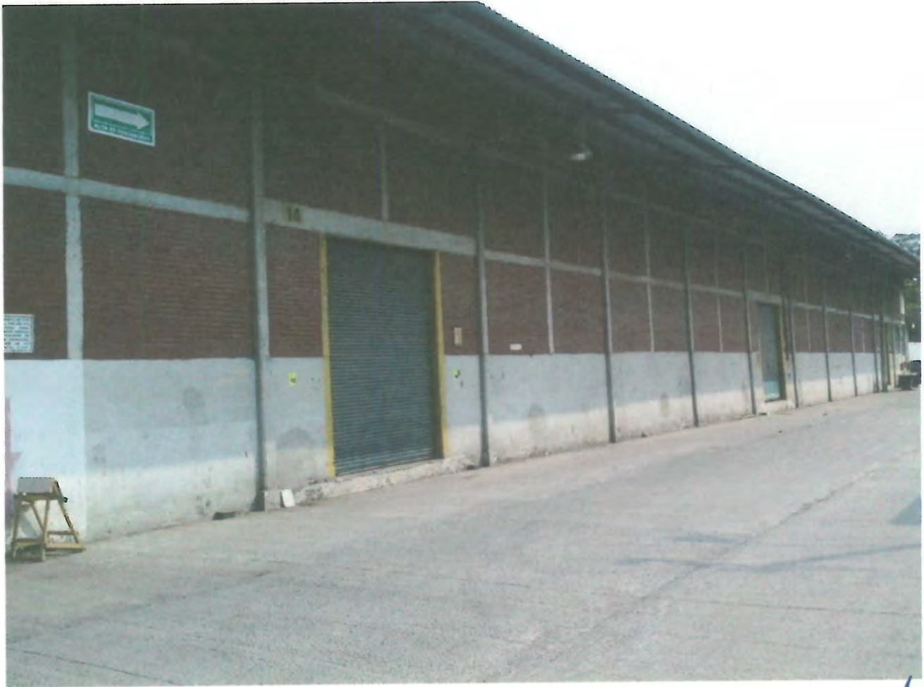
FACHADA SIN DAÑOS
