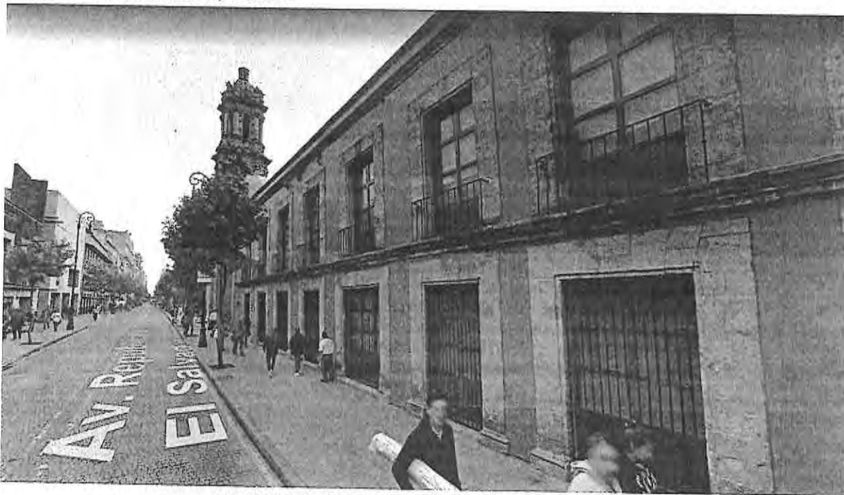
FACHADA POR LA CALLE REPÚBLICA DE EL SALVADOR
