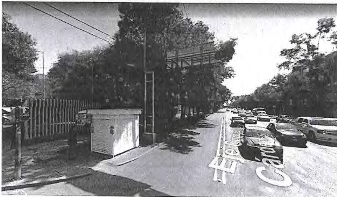
FACHADA POR EL EJE CENTRAL LAZARO CARDENAS
