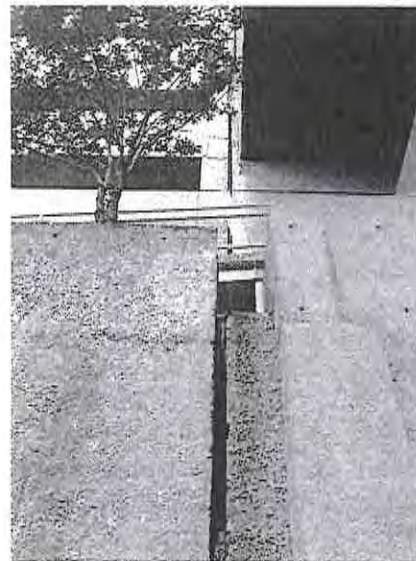
NERVADURAS Y JUNTA CONSTRUCTIVA
