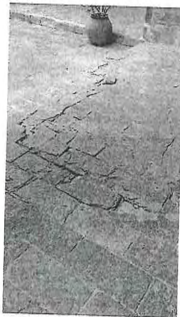
ARCOS Y EL ASENTAMIENTO SE REFLEJA EN EL PISO
