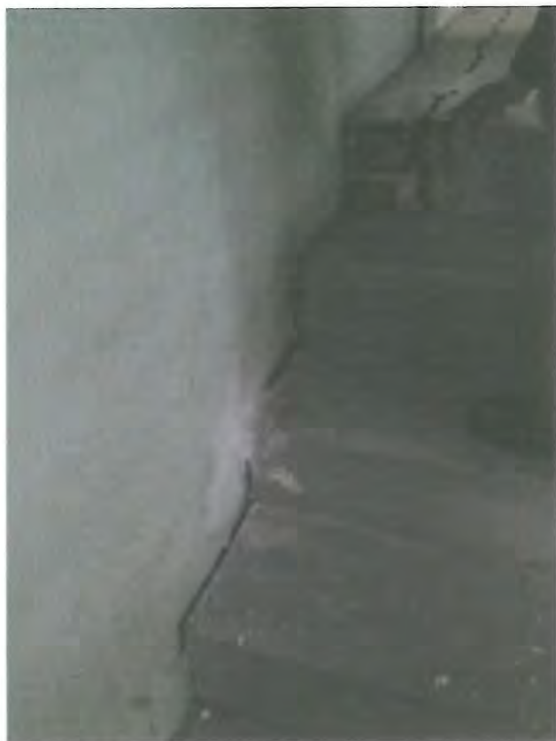
FOTO 01.- SEPARACION DE MUROS CON ESCALONES POR SER DOS ELEMENTOS DIFERENTES
