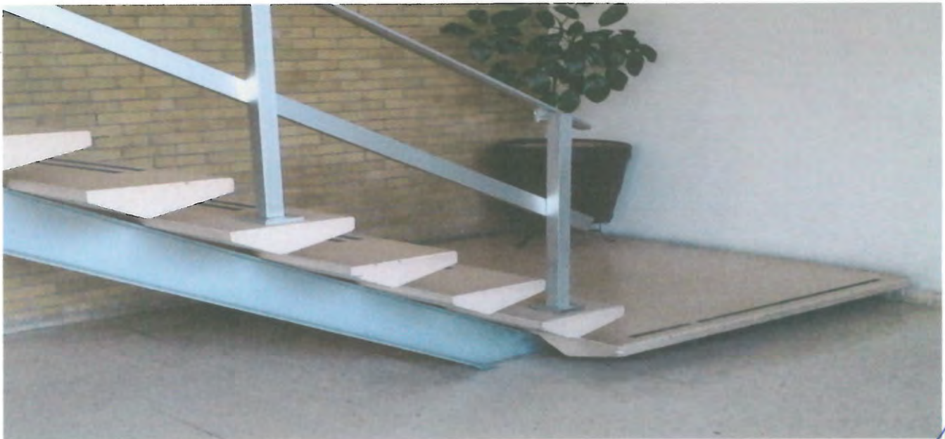
ESCALERAS SIN DAÑOS
