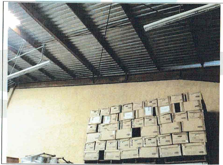
Foto 4. Trabes y largueros de estructuras principales en bodegas.
