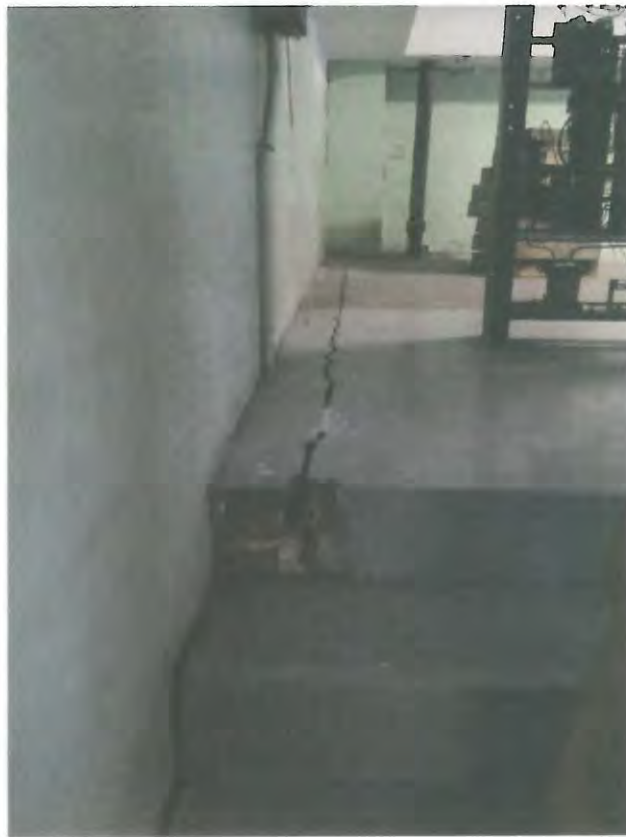
FOTO 01.- SEPARACION DE MUROS CON ESCALONES POR SER DOS ELEMENTOS DIFERENTES
