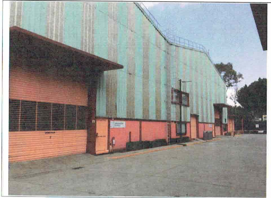
Foto 7. Vista exterior de bodegas 1 y 2.
