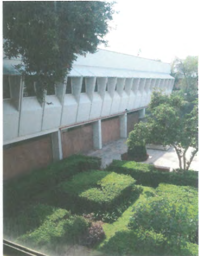
FACHADAS SIN DAÑOS
