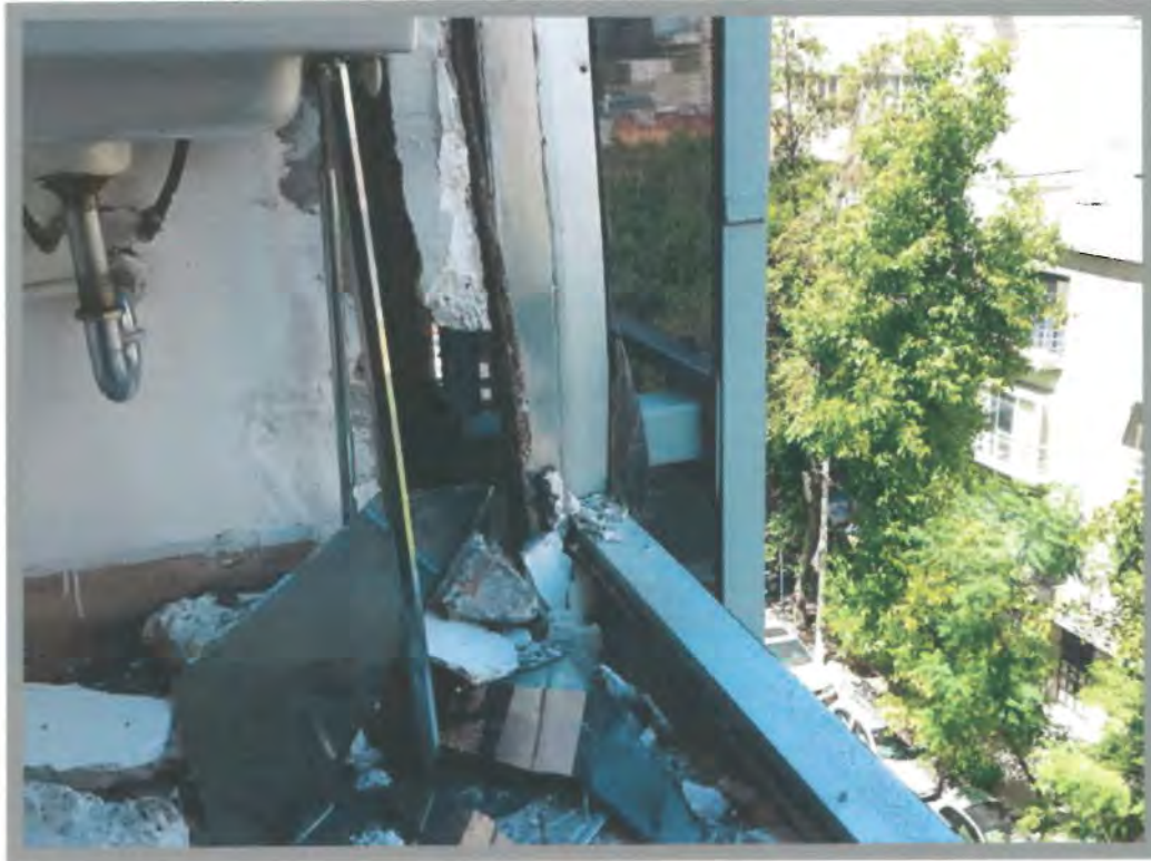
Foto 3 Choque de la cancelería del vecino con la del edificio del SAT
