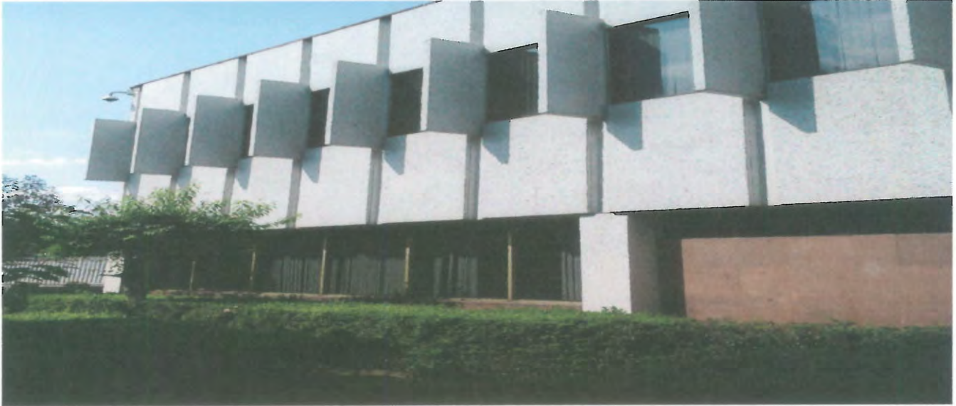
FACHADA SIN DAÑOS
