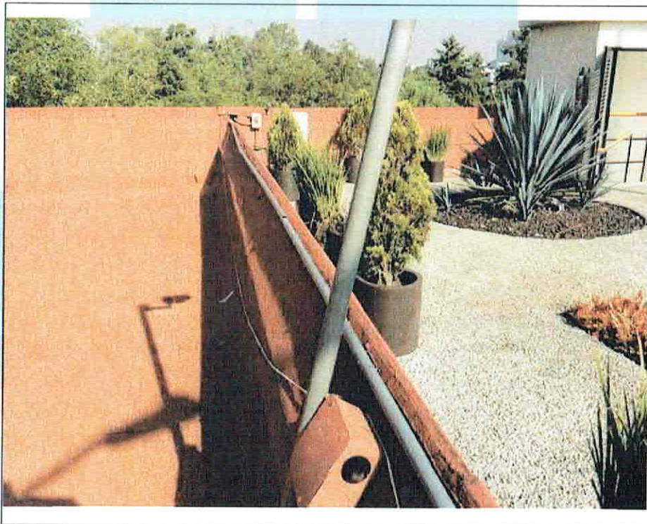
Foto 8. Junta constructiva entre estructuras que conforman al edificio (vista exterior).
