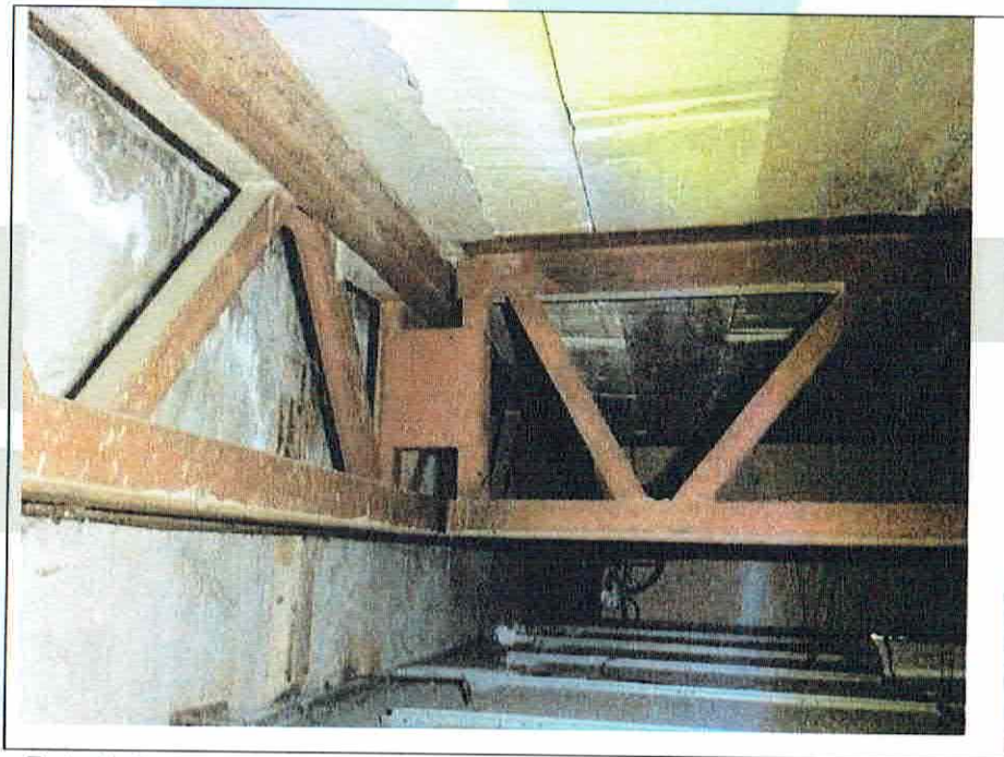
Foto 4. Se muestra el sistema de losa a base de casetones, así como celosías sin daños postsismo.
