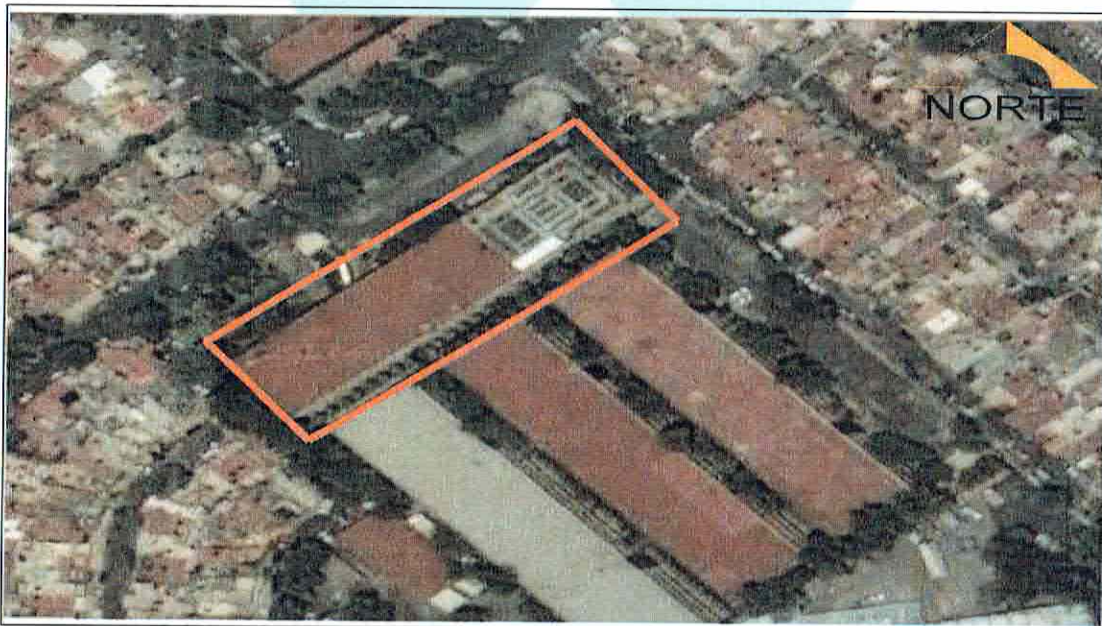
Ubicación del predio evaluado. Calzada de la Virgen No. 2799, Edificio "A", Col. CTM Culhuacán, Del. Coyoacán, Ciudad de México, C.P. 04480.
