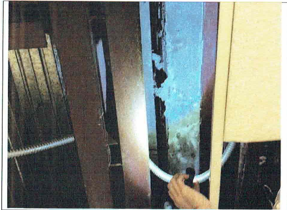
Foto 7. Junta constructiva entre estructuras que conforman al edificio (vista interior).
