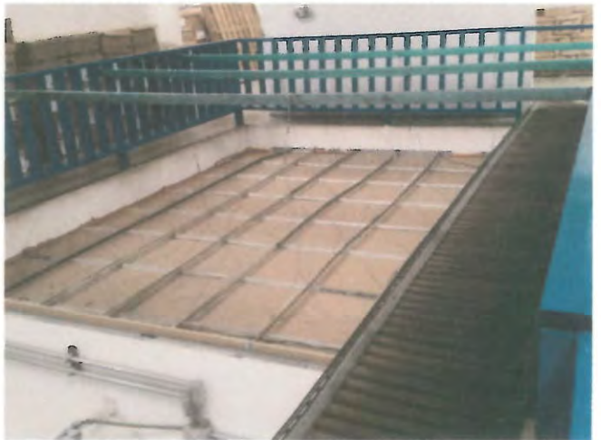
FALSO PLAFON COLOCADO A NIVEL DE LOSA
