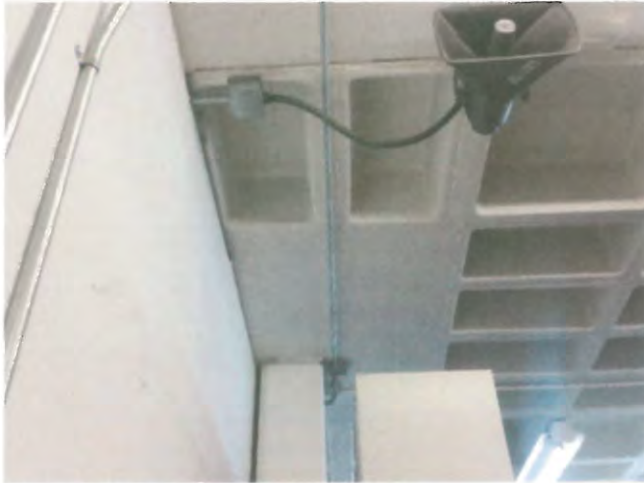
CAPITEL Y CASETONES DE LOSA P.B.
