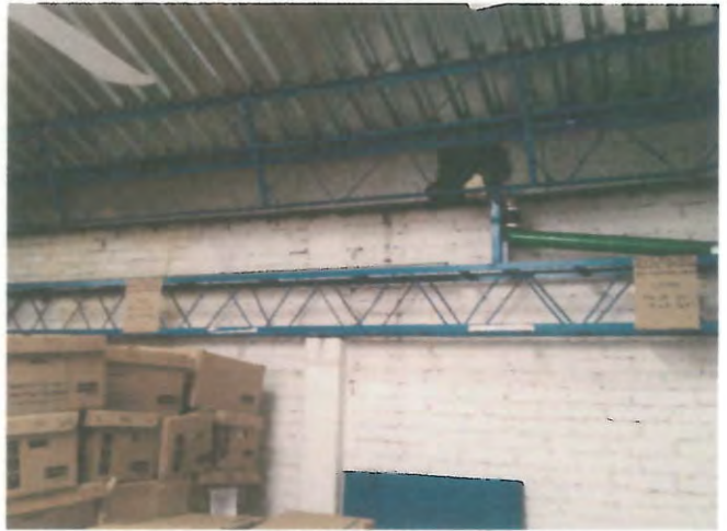
ESTRUCTURA DE TECHUMBRE PLANTA ALTA
