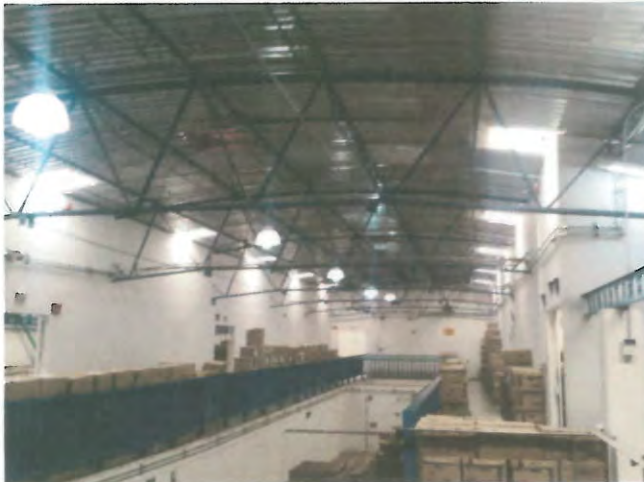
ESTRUCTURA DE TECHUMBRE PLANTA ALTA
