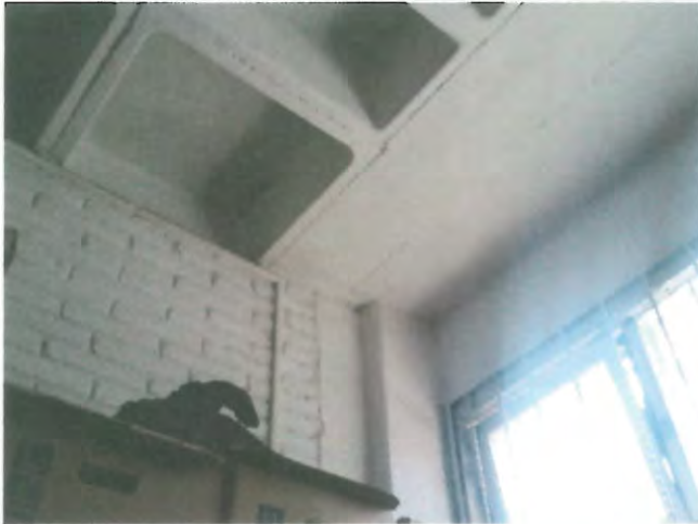
CAPITEL Y CASETONES DE LOSA P.B.
