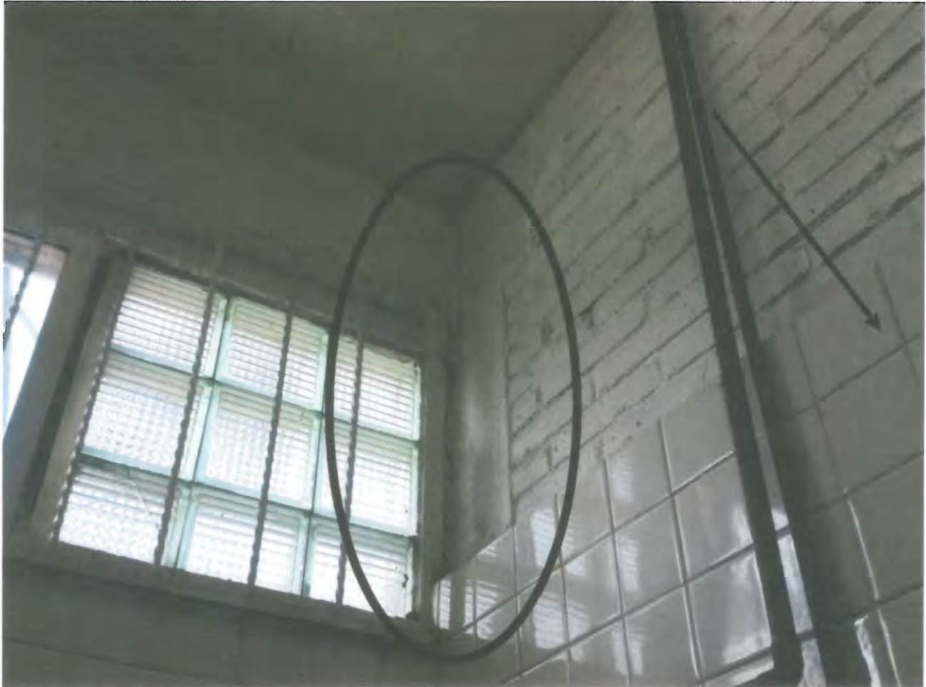
FOTO 01.- MANTENIMIENTO GENERAL A SANITARIO
