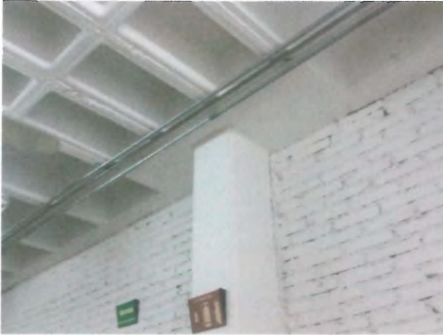
CASETONES DE LOSA PLANTA BAJA
