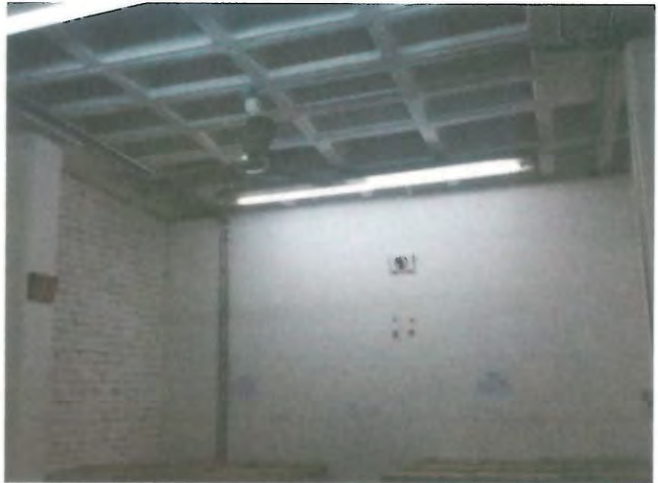
CASETONES DE LOSA PLANTA BAJA
