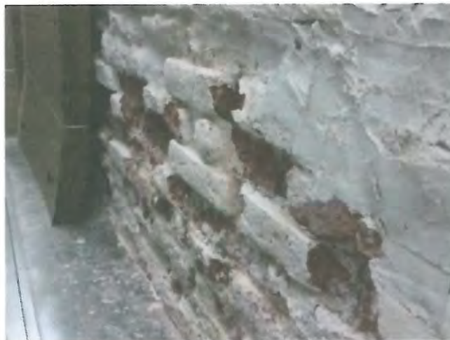
FOTO 03.- HUMEDADES EN MUROS PERIMETRALES.
