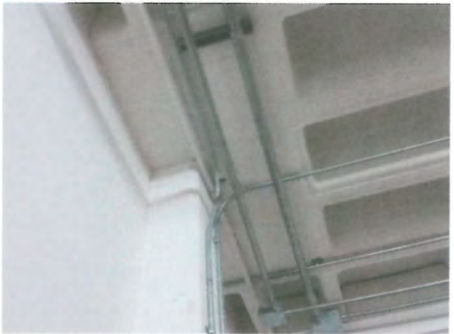
COLUMNA Y CASETONES DE LOSA PLANTA BAJA
