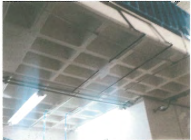
ESTRUCTURA EN PLANTA BAJA DE ALMACEN
