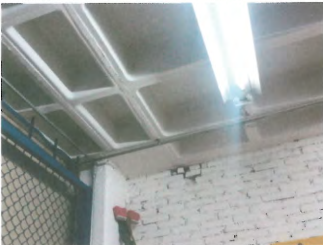
ESTRUCTURA EN PLANTA BAJA DE ALMACEN
