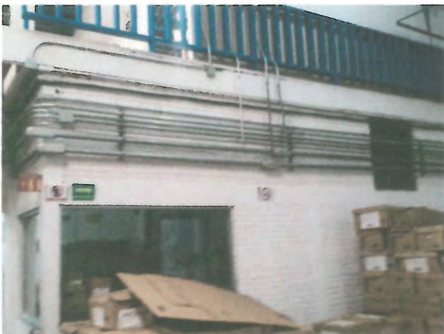
ALMACEN PLANTA BAJA
