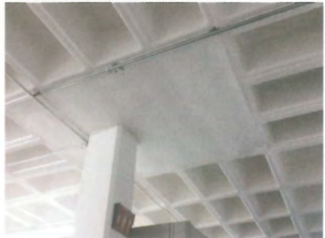
CAPITEL Y CASETONES DE LOSA P.B.
