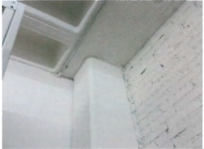
CAPITEL Y CASETONES DE LOSA P.B.
