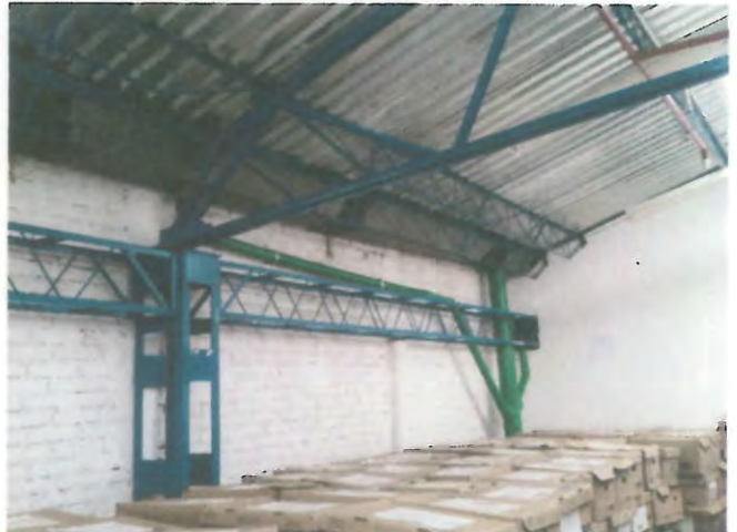
ESTRUCTURA DE TECHUMBRE PLANTA ALTA
