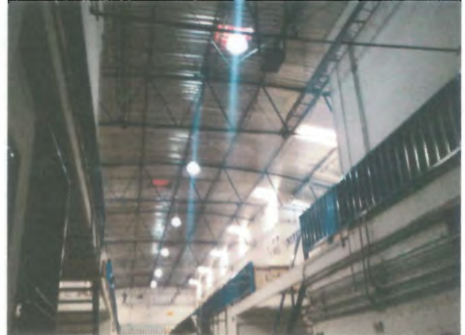
TECHUMBRE DE ALMACEN GENERAL
