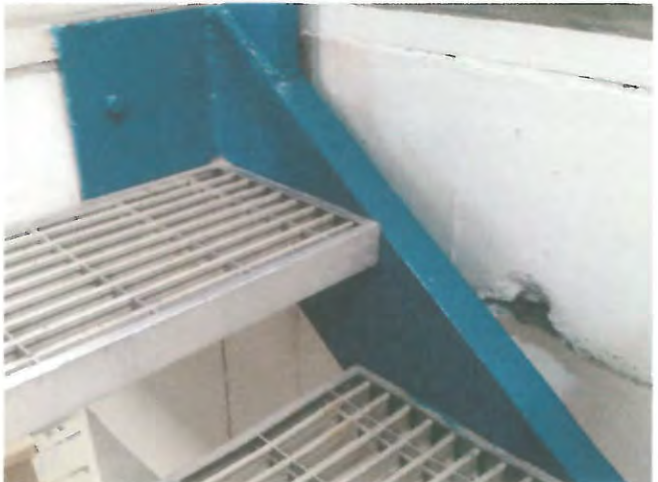
ESTRUCTURA DE ESCALERA
