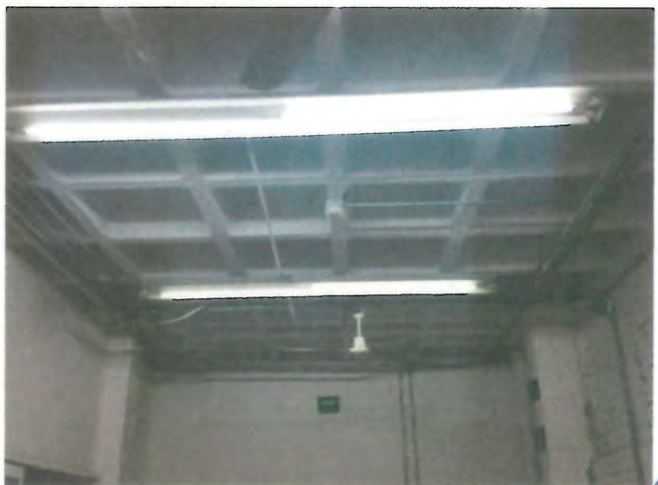
CASETONES DE LOSA EN PLANTA BAJA
