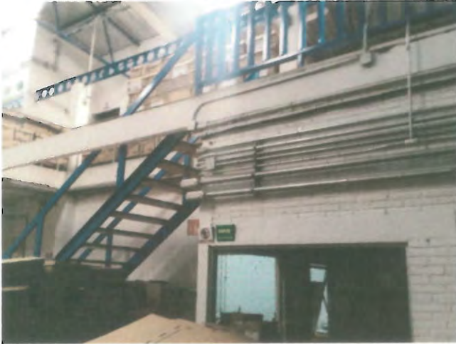
ESCALERA A PLANTA ALTA DE ALMACEN GENERAL
