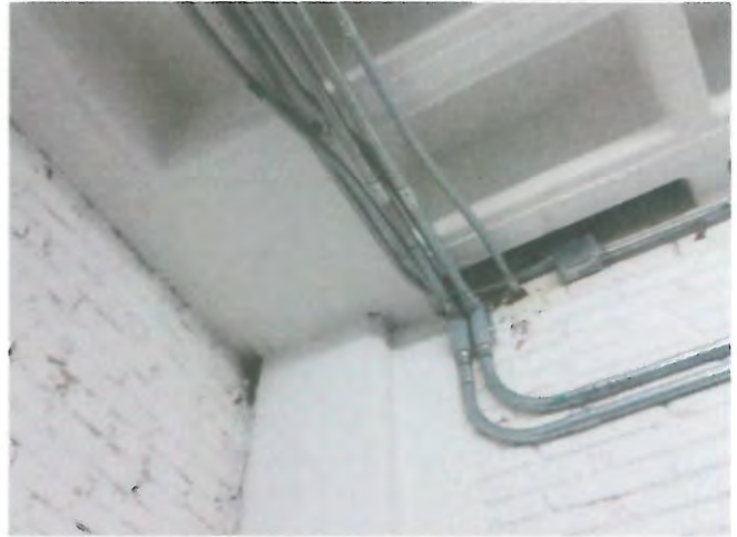
CAPITEL Y CASETONES DE LOSA P.B.
