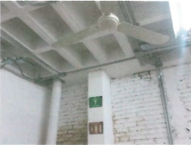
CASETONES DE LOSA PLANTA BAJA
