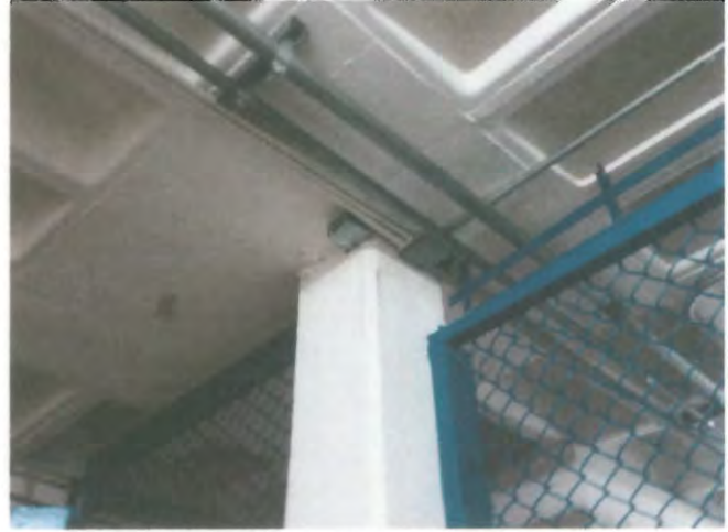
ESTRUCTURA EN PLANTA BAJA DE ALMACEN
