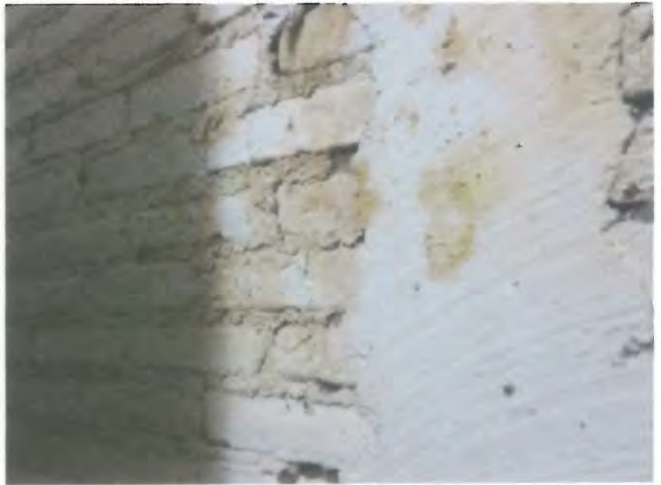
FOTO 03.- HUMEDADES EN MUROS PERIMETRALES.
