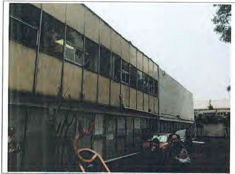
Foto 5. Fachada exterior del inmueble. No se observan fallas.
