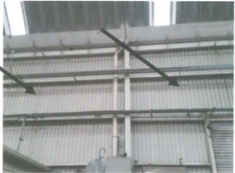
FOTO 01.- DAR TORQUE A LOS TENSORES VERTICALES ENTRE MONTENES HORIZONTALES.
