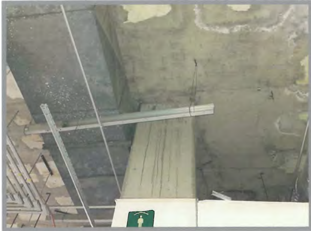
Foto 2 No hay daño estructural en columnas ni capiteles (unión de losa con columnas)
