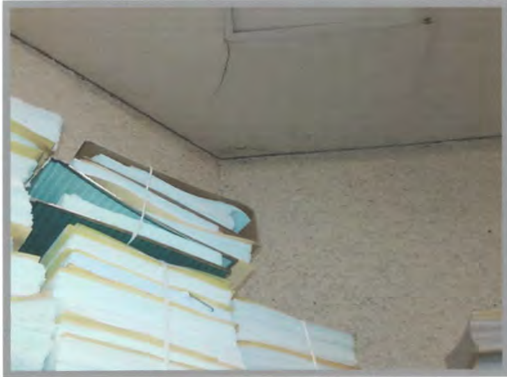
Foto 18 Separación entre plafón y columnas (No es daño estructural)
