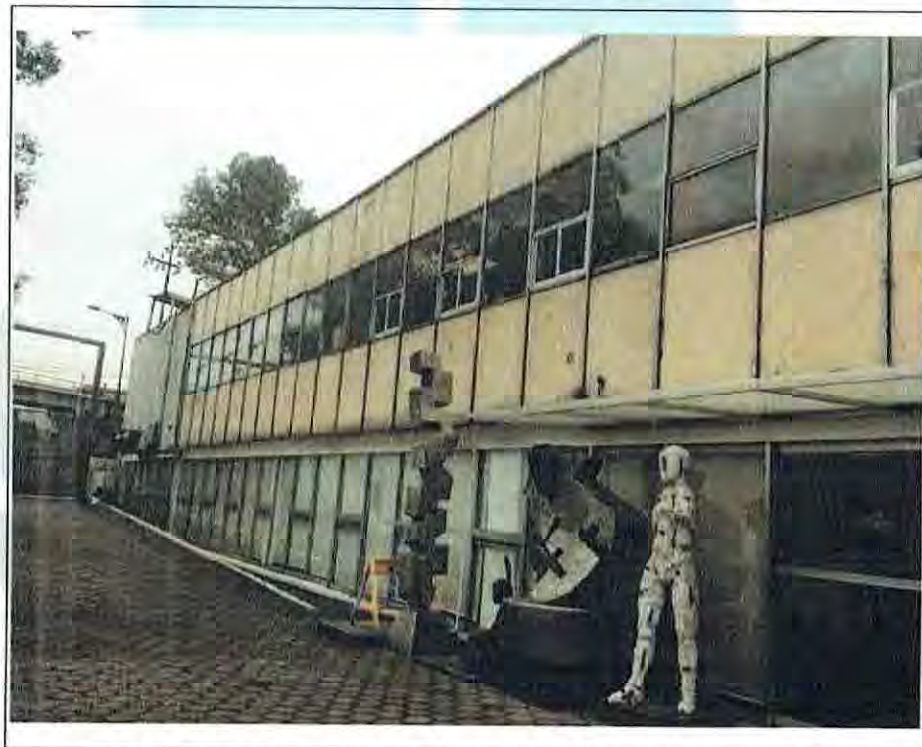
Foto 6. Fachada exterior del inmueble. No se observan fallas.
