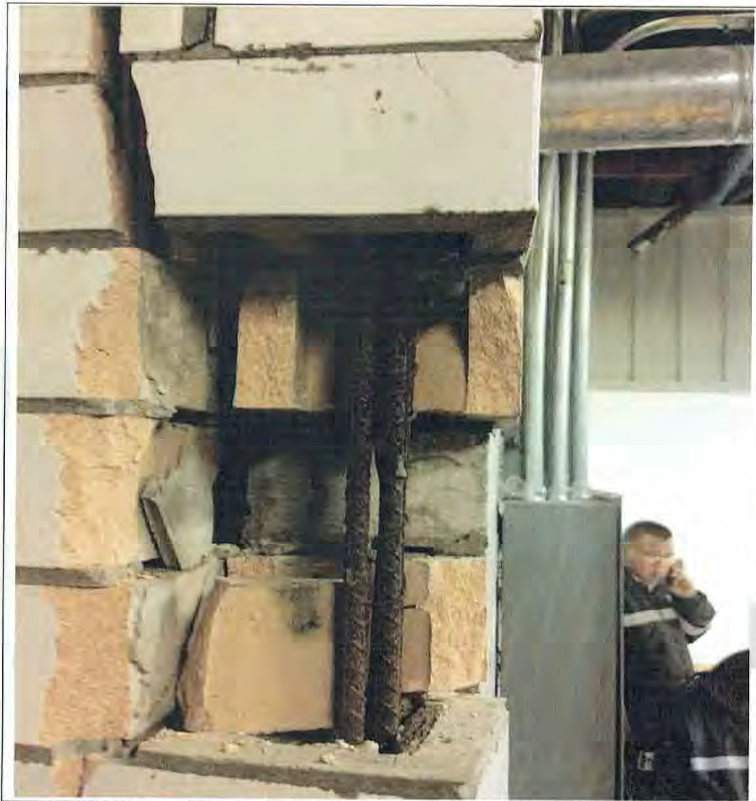
Foto 10. Se observa con detalle la carencia de concreto en el elemento.
