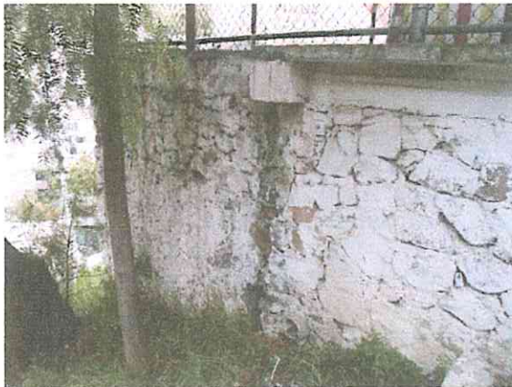
Foto 7 y 8. Muros de contención con algunas fisuras.
