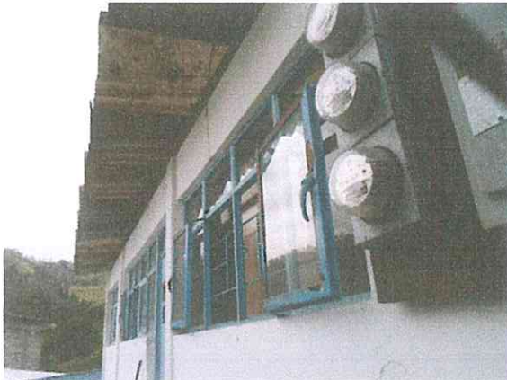
Foto 5 y 6. Fachada interior y exterior del cuerpo de mampostería con techumbre de asbesto.
