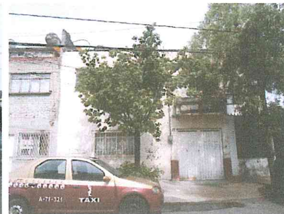
Foto 3 y 4. Fachada principal que presenta un desplome hacia su interior.
