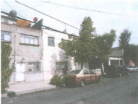
Foto 1 y 2. Fachada principal que presenta un desplome hacia su interior.
