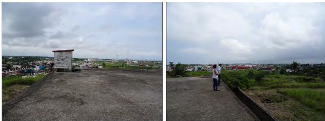
Figura 17 Tanque poniente, es un tanque de regularización con una capacidad de 3000 m 3
