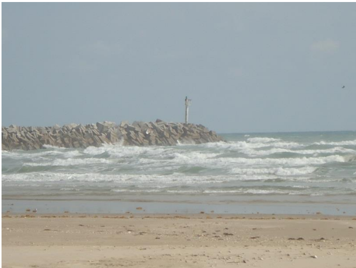
Panorámica de la escollera en la Laguna Madre. Se detecta presencia de grasas y aceites.
