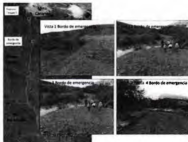
Figura 1.2 Bordo de contención construido para controlar el avance de la solución derramada del Represo Tinaja 1
