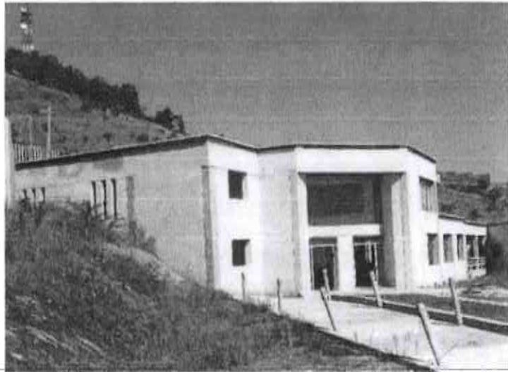
Imagen 5. Edificio Administrativo. Fachada oriente.
