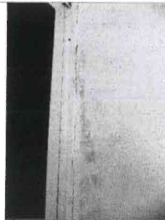
Imagen 16. Filtración de humedad en muros
