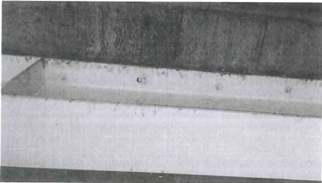
ANCLAJE A LA LOSA DE LA VIGA DE REFUERZO
