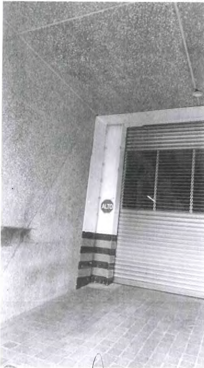
REFUERZO METALICO DE ACCESO A ESTACIONAMIENTO.
