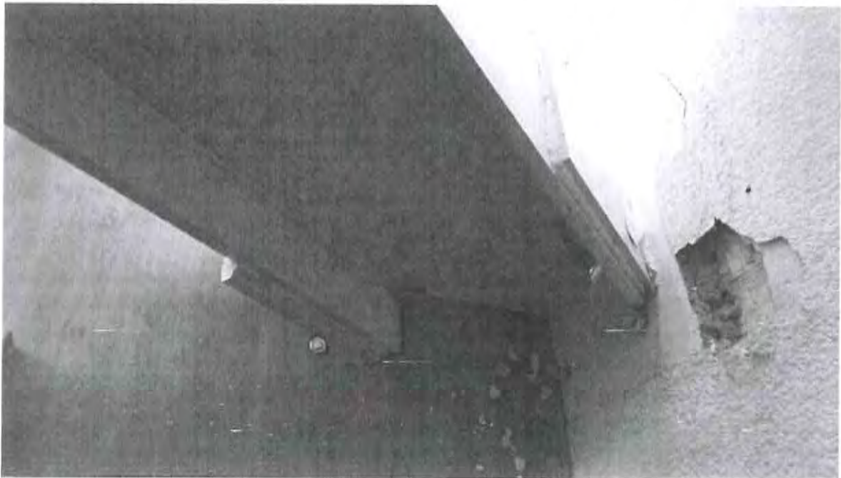
CONTRAVIENTO METÁLICO PARA RIGIDIZAR EL EDIFICIO
