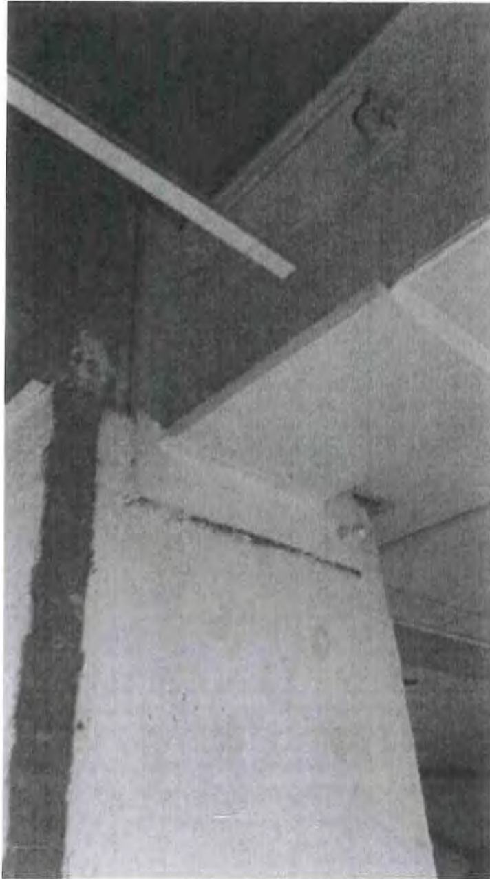
ANCLAJES ASIMETRICOS, DE VIGAS METALICAS DE REFUERZO
