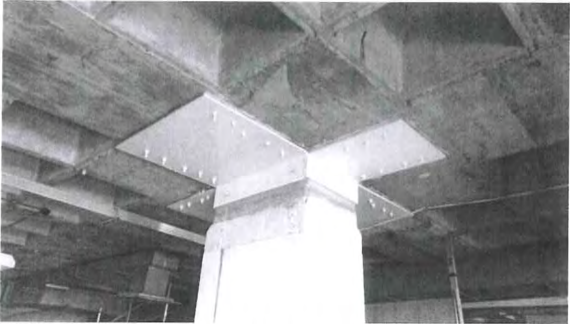
REFUERZO METALICO EN CAPITELES DE LOSA RETICULAR.
