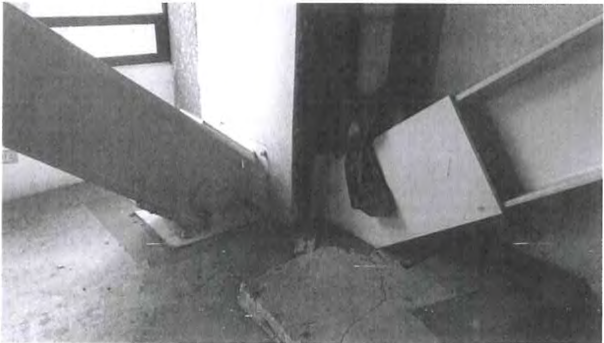
CONTRAVIENTOS METALICOS LLEGANDO A UNA MISMA COLUMNA
