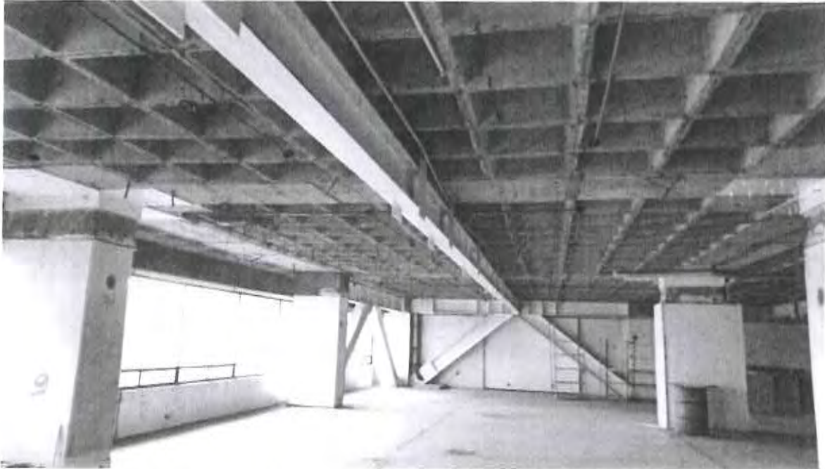
VIGA METALICA PARA REFORZAR LA LOSA RETICULAR
