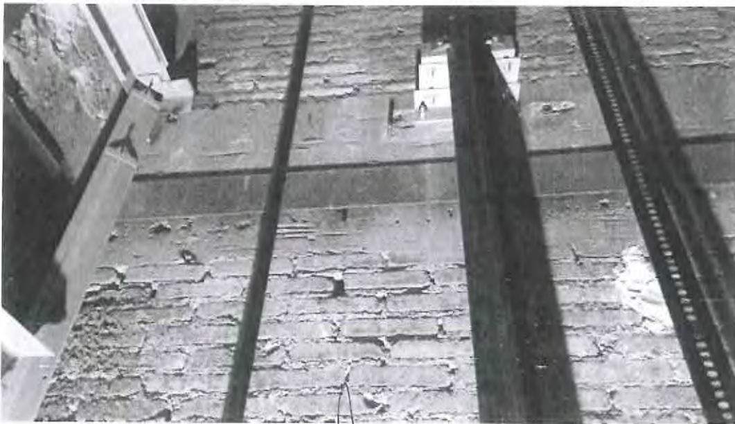
DETALLE DE MUROS AL INTERIOR DE DUCTOS DE ELEVADOR.
