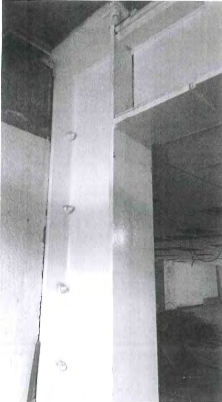
MARCO METALICO, ADICIONADO A LA ESTRUCTURA COMO REFUERZO
