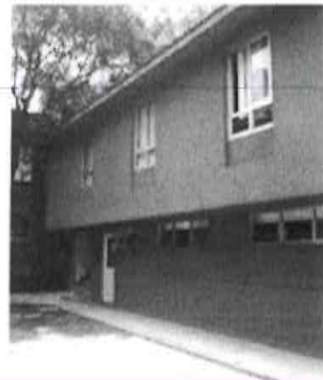
Imagen 16. Fachada Oriente del Archivo General
