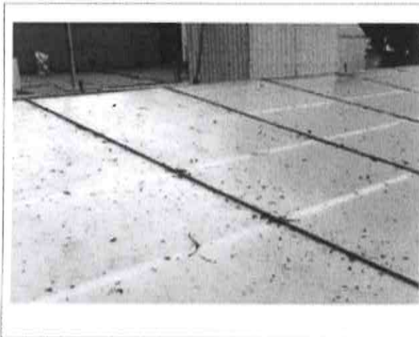
Imagen 9. Falta de mantenimiento en domos de policarbonato
