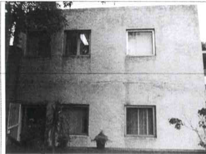
Imagen 7. Fachada primer edificio
