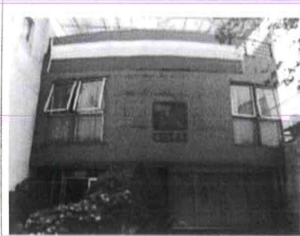
Imagen 5. Fachada interior poniente
