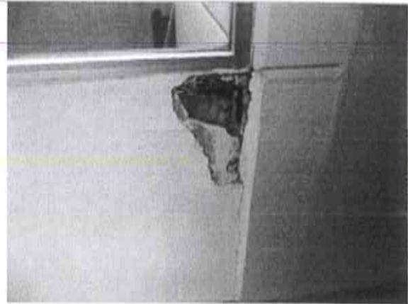
Imagen 20. Desprendimiento de antepecho del Puente
