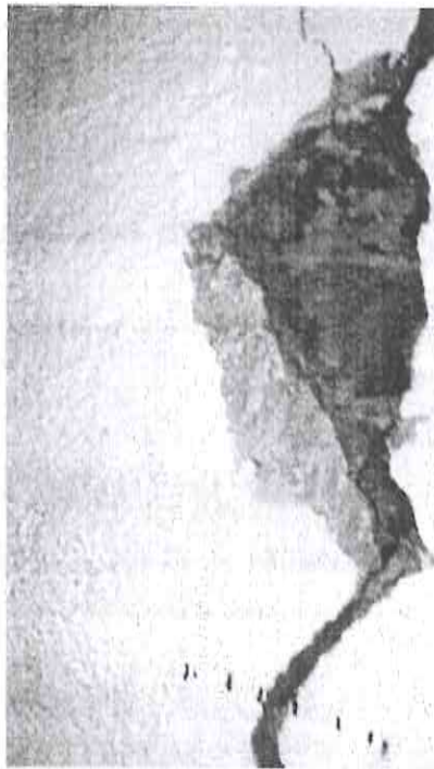
AGRIETAMIENTOS EN MURO ESQUINA SUROESTE
