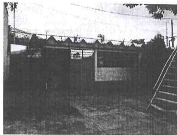
ESTRUCTURA PRINCIPAL NAVE 7
