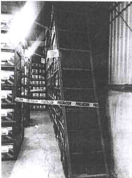
ASENTAMIENTO DIFERENCIAL EN PISOS Y AGRIETAMIENTOS
