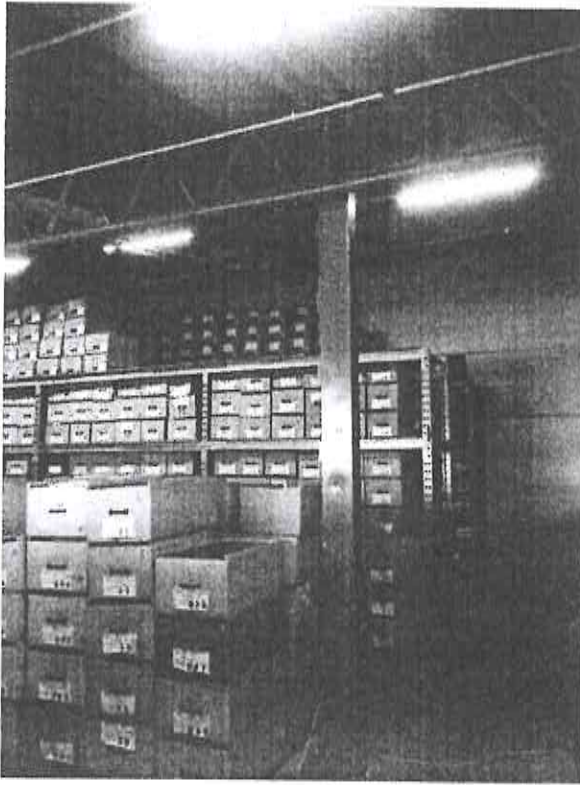
COLUMNA EN CAJON CON PERFIL TIPO MONTEN
