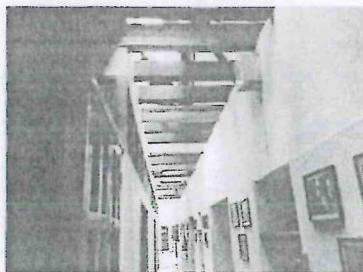
Foto 5.- Muros interiores, vigas y cubierta en buen estado.
