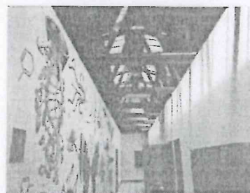
Foto 10.- Armaduras de madera y cubierta en buen estado.
