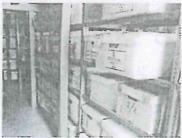
Foto 41.-Columna pandeada en el área de archivo.
