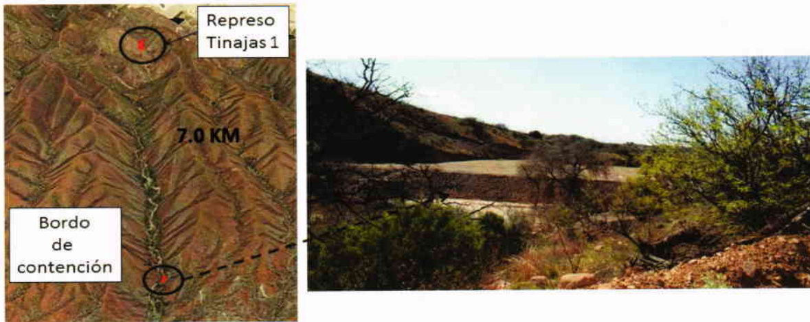
Figura 1.2 Bordo de contención construido para controlar el avance de la solución derramada del Represo Tinaja 1
