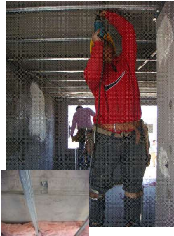
Aislamiento térmico en losas con fibra de vidrio
