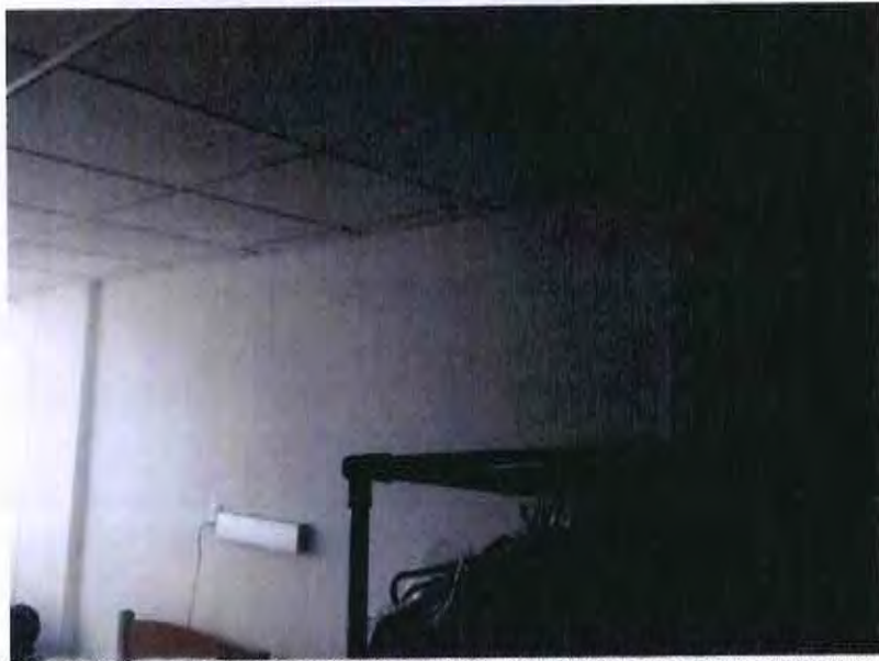
FOTOGRAFÍA 23. MURO DE CONCRETO EN BUEN ESTADO SIN FISURAS NI DEFORMACIONES QUE PONGAN EN RIESGO LA ESTABILIDAD DEL EDIFICIO. PLAFÓN SIN ALTERACION ALGUNA.
