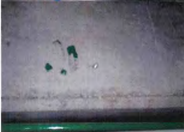
FOTOGRAFÍA 6. NIVEL 1 TRABE DE ESTRUCTURA PRINCIPAL SIN AFECTACIÓN EN LA ESTABILIDAD DEL EDIFICIO.
