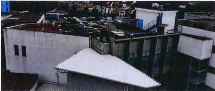
FOTOGRAFÍA 16. VISTA GENERAL DE LA AZOTEA Y CUBIERTAS. LAS CUBIERTAS SE OBSERVAN EN BUEN ESTADO, SIN DEFORMACIONES, NI DAÑO APARAENTE.
