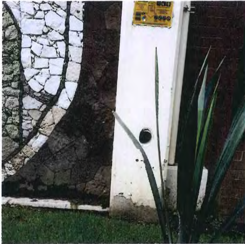
FOTOGRAFÍA 1. COLUMNA DE PLANTA BAJA EN FACHADA CON SEÑALES DE QUE SE LE REALIZARON MUESTRAS PARA LABORATORIO.
