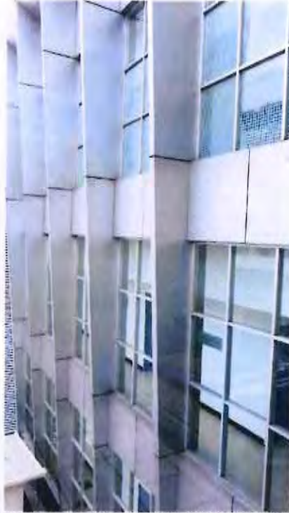
FOTOGRAFÍA 11. FACHADA POSTERIOR. SIN ROTURA DE VIDRIOS O CAÍDA DE ACABADOS. EN BUEN ESTADO.
