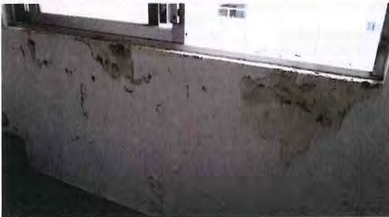
FOTOGRAFÍA 16. EN ZONA DE ESCALERA. MURO CON DESCARPELAMIENTO DE ACABADOS DEBIDO A LA HUMEDAD, SIN AFECTACIÓN DE LA ESTRUCTURA.
