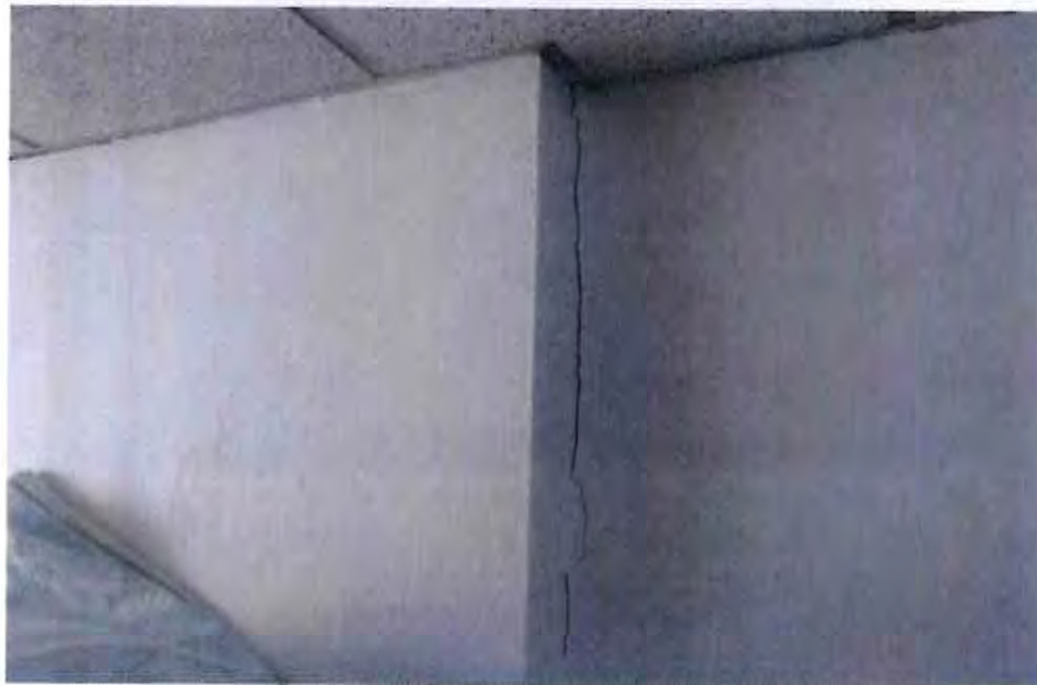
FOTOGRAFÍA 13. FISURA VERTICAL EN UNION ENTRE MURO CON COLUMNA.
