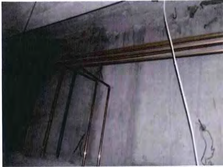
FOTOGRAFÍA 22. PASO DE INSTALACIONES EN BUEN ESTADO.
