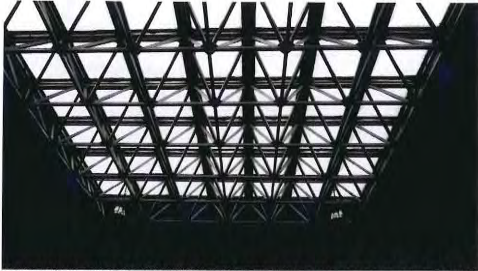
FOTOGRAFÍA 43. CUBIERTA DE TRIDILOSA EN PATIO NTERIOR EN EJES 3-6, G-I, EN BUEN ESTADO, SIN DEFORMACION O DETERIORO DE SUS ELEMENTOS.
