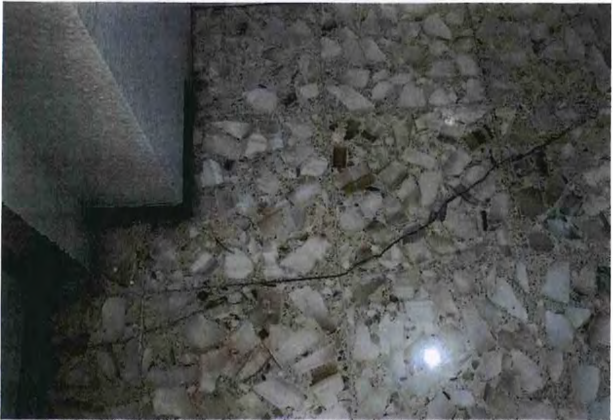
FOTOGRAFÍA 19. COLUMNA EN BUEN ESTADO SIN FRACTURA, SIN DEFORMACIÓN. PISO CON ACABADO FRACTURADO.
