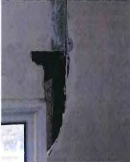
FOTOGRAFÍAS 50. MURO INTERIOR DIVISORIO EN FACHADA.
