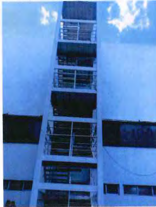
FOTOGRAFÍA 43. ACABADOS DE FACHADA EN BUEN ESTADO, SIN DESPRENDIMIENTO O CAÍDAS.
