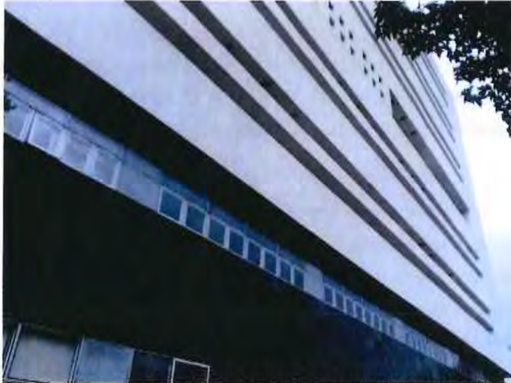
FOTOGRAFÍA 90. FACHADA EN BUEN ESTADO, SIN DESPRENDIMIENTO NI FISURAS EN ELEMENTOS.
