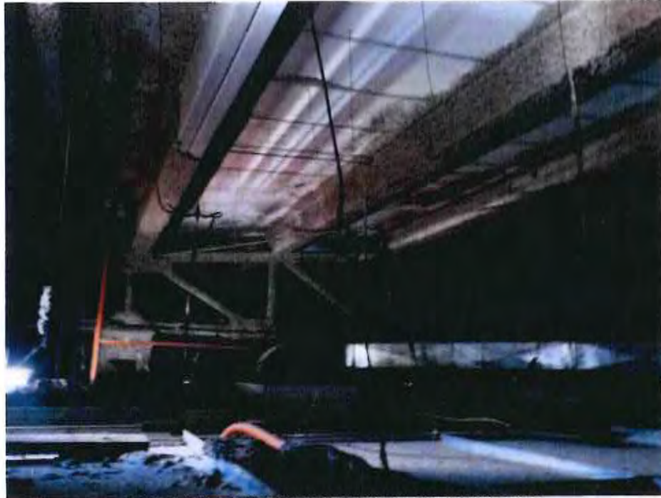
FOTOGRAFÍA 10. ESTRUCTURA METÁLICA CON MULTYTECHO.
