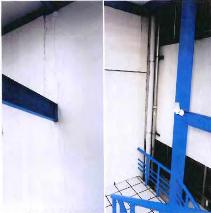
FOTOGRAFÍA 9. EN ZONA DE LA ESCALERA, DEL NIVEL 2 AL NIVEL 3. FISURAS VERTICALES EN EL ACABADO QUE CUBRE LA ESTRUCTURA METÁLICA.
