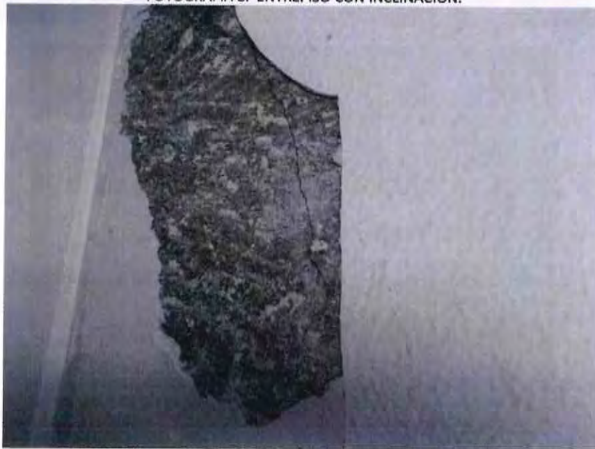
FOTOGRAFÍA 9. FISURA EN CASTILLO DE MURO DIVISORIO DE ESCALERA.
