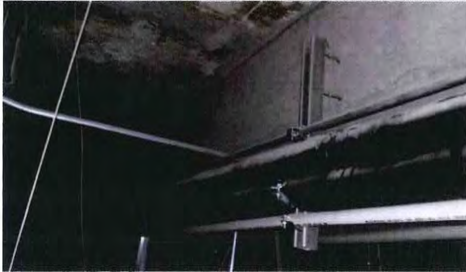
FOTOGRAFÍA 21. NIVEL 2. TRABE DE ESTRUCTURA PRINCIPAL SIN FISURAS NI DEFLEXIONES, LOSA DE SISTEMA DE VIGUETA Y BOVEDILLA EN BUEN ESTADO, INSTALACIONES SIN INTERRUPCIÓN O DEFORMACIÓN.
