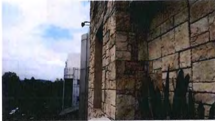
FOTOGRAFÍA 14. Balcón en nivel 4. aparentemente no se observan fisuras en acabados.
