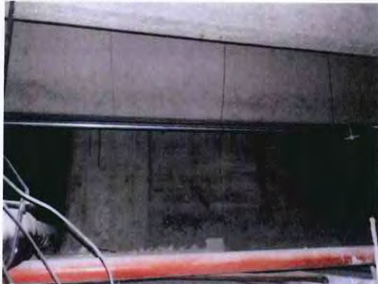
FOTOGRAFÍA 24. MURO DE CONCRETO CON TRABE EN BUEN ESTADO.
