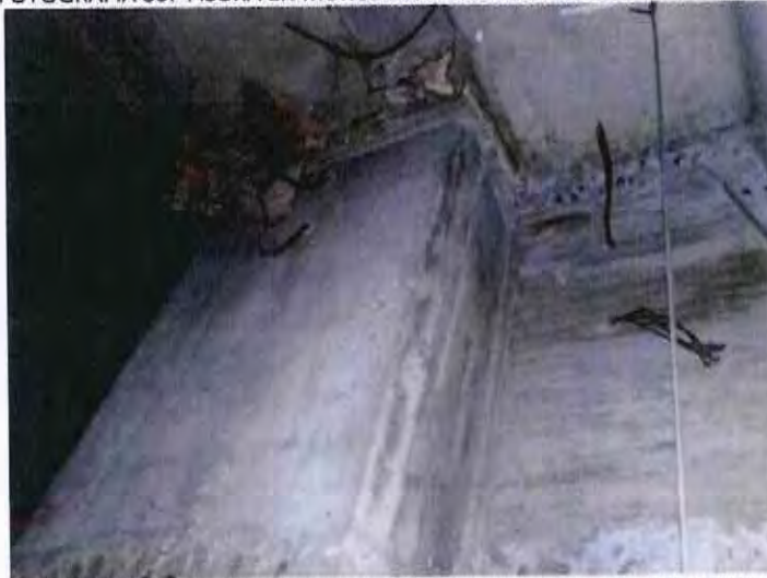
FOTOGRAFÍA 31. NODO DE COLUMNA Y TRABE DE CONCRETO PRINCIPAL.
