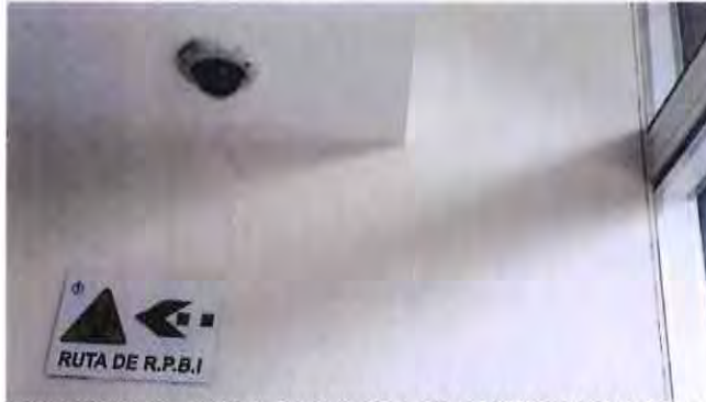
FOTOGRAFÍA 34. FISURAS VERTICALES EN ESQUINAS DE MUROS DIVISORIOS CON CANCELERÍA Y EN MUROS EN ZONA DE ESCALERA.
