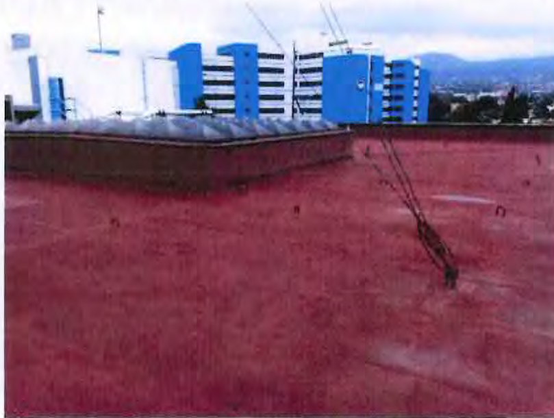
FOTOGRAFÍA 46. AZOTEA, LA LOSA NO PRESENTA DEFLEXIONES O FRACTURAS APARENTES, EL PRETIL Y LOS DOMOS SE OBSERVAN EN BUEN ESTADO.
