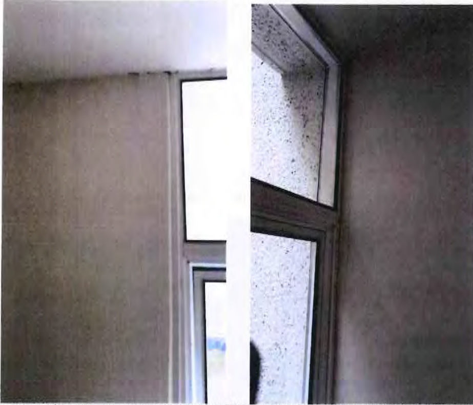
FOTOGRAFÍA 28-29. FISURAS VERTICALES EN MUROS DIVISORIOS EN FACHADAS EN PLANTA BAJA.
