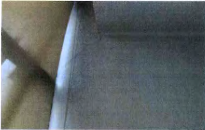
FOTOGRAFÍA 12. FISURA EN MURO DIVISORIO, SIN AFECTACIÓN A ELEMENTOS ESTRUCTURALES.
