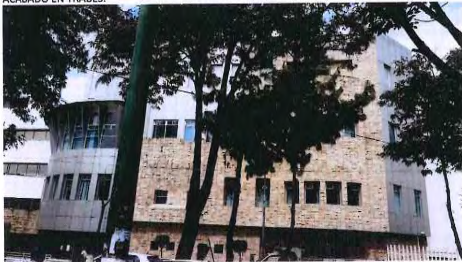
FOTOGRAFÍA 18. FACHADA PRINCIPAL, SIN ROTURA DE VIDRIOS NI DESPRENDIMIENTO DE ACABADOS.
