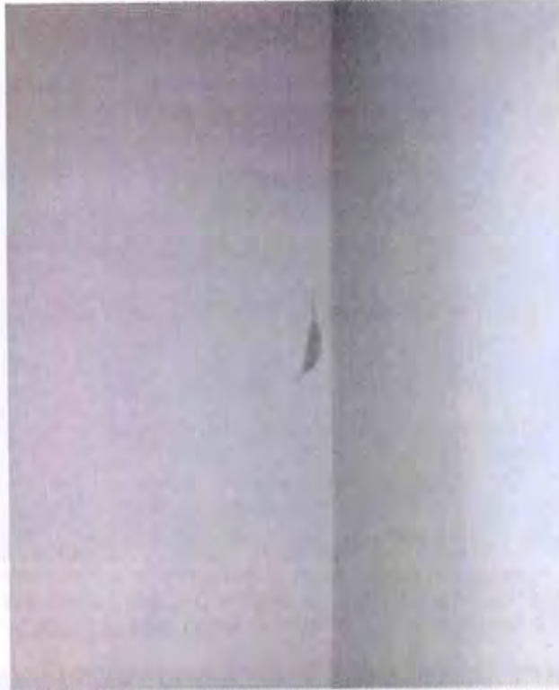
FOTOGRAFÍA 30. FISURA EN MUROS DIVISORIOS DE TABIQUE ROJO RECOCIDO.
