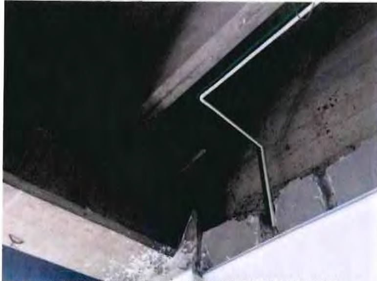
FOTOGRAFÍA 36. TRABE DE CONCRETO EN LA DIRECCIÓN CORTA.
