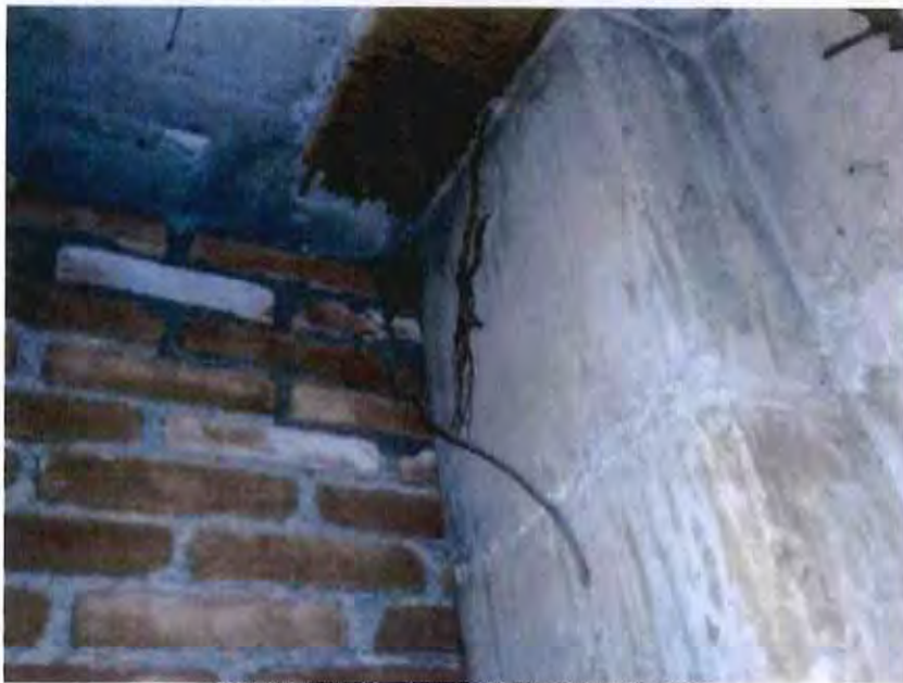
FOTOGRAFÍA 41. COLUMNA EN BUEN ESTADO. NO EXISTE TRABE NI MURO DE CONCRETO EN LA DIRECCIÓN CORTA EN LA COLINDANCIA.
