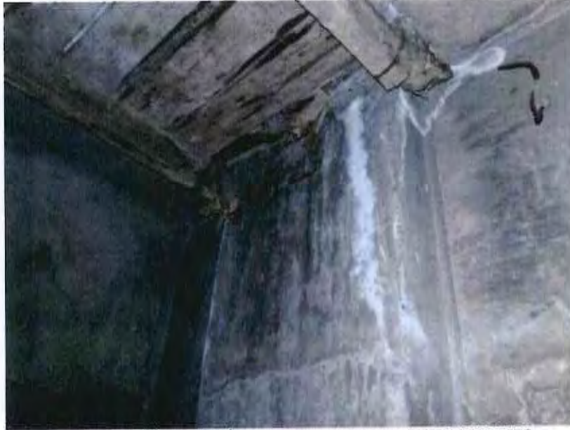
FOTOGRAFÍA 18. UNIÓN DE TRABES CON COLUMNA DE CONCRETO.
