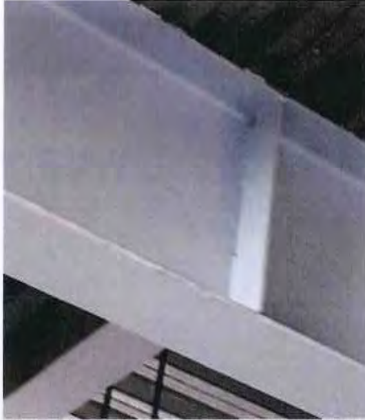
FOTOGRAFÍA 26. REFUERZO EN TRABE CON SOLDADURA.
