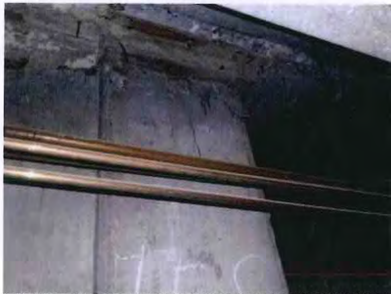
FOTOGRAFÍA 21. COLUMNA, MURO Y TRABE EN BUEN ESTADO, SIN DEFORMACIONES O DEFLEXIONES.
