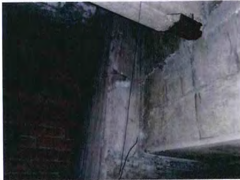
FOTOGRAFÍA 27. NODO DE COLUMNA Y TRABE DE CONCRETO PRINCIPAL Y VIGA DOBLE T. MURO DE TABIQUE SIN CASTILLO EN EXTREMO DE MURO PARA DESLIGAR DE LA ESTRUCTURA PRINCIPAL
