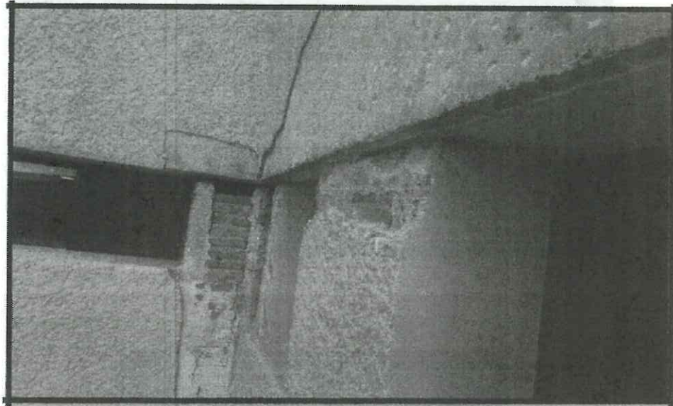
Elementos estructurales (columna y trabe) sin daño.
