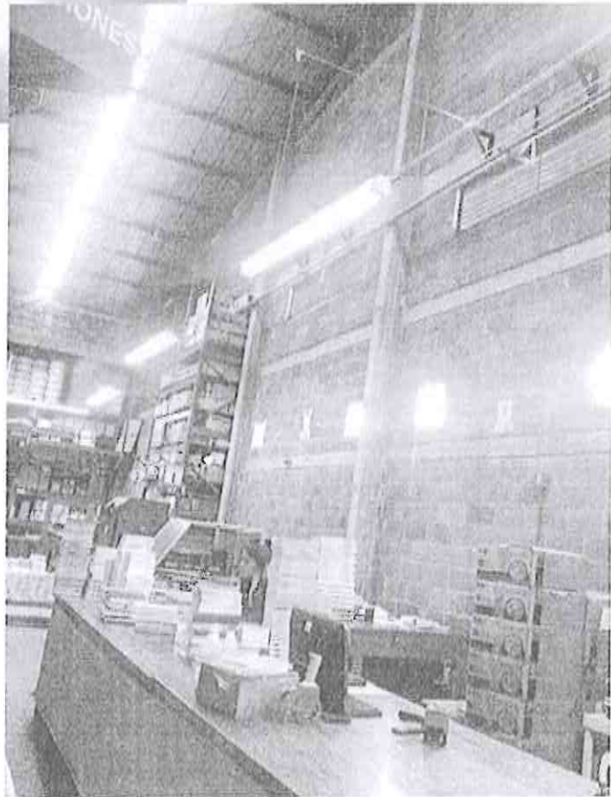
MUROS DE BLOCK CON COLUMNAS DE CONCRETO
