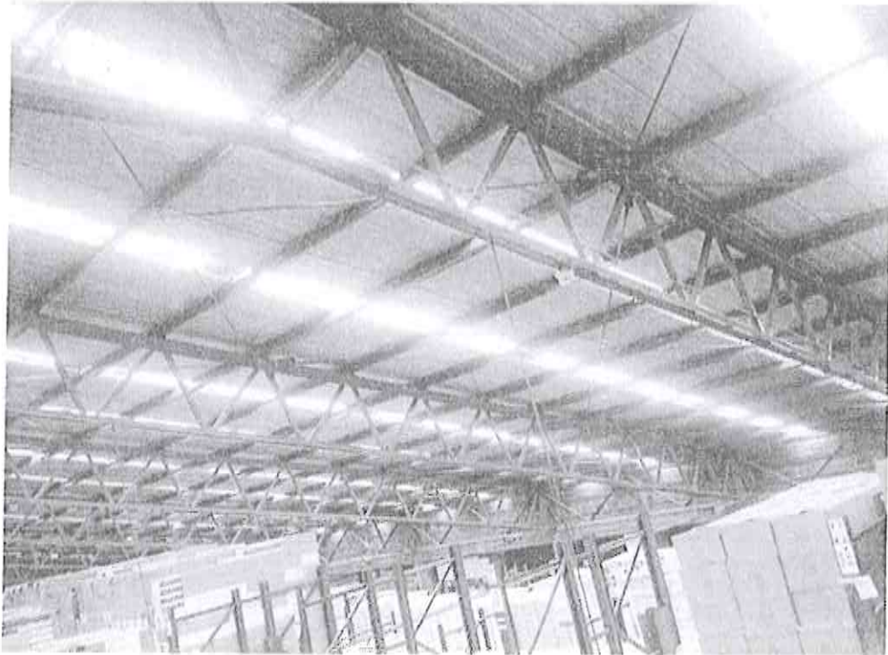
ARMADURAS METÁLICAS
