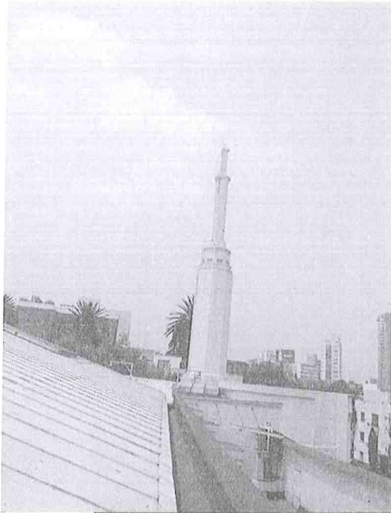
TORRE ORIGINAL DE CONCRETO
