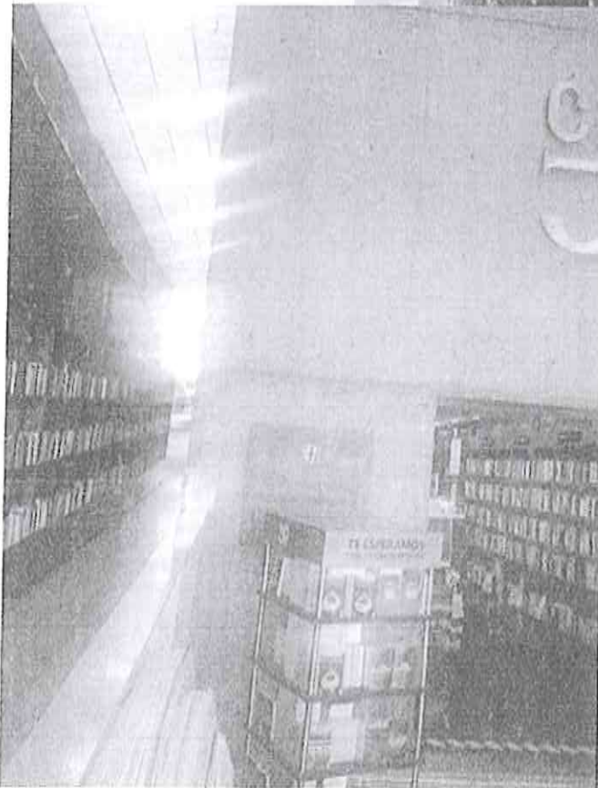
MURO DE CONCRETO EN INTERIOR DE LIBRERÍA
