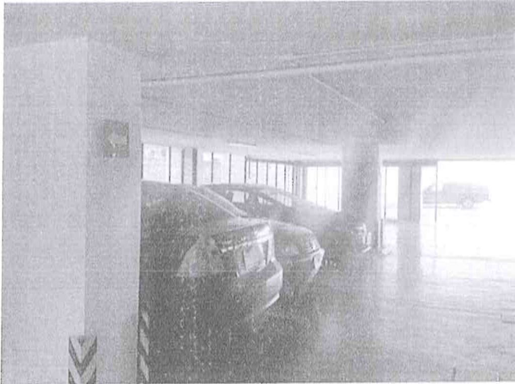
ESTACIONAMIENTO EN LA PLANTA BAJA CON COLUMNAS DE CONCRETO Y LOSA PLANA ALIGERADA
