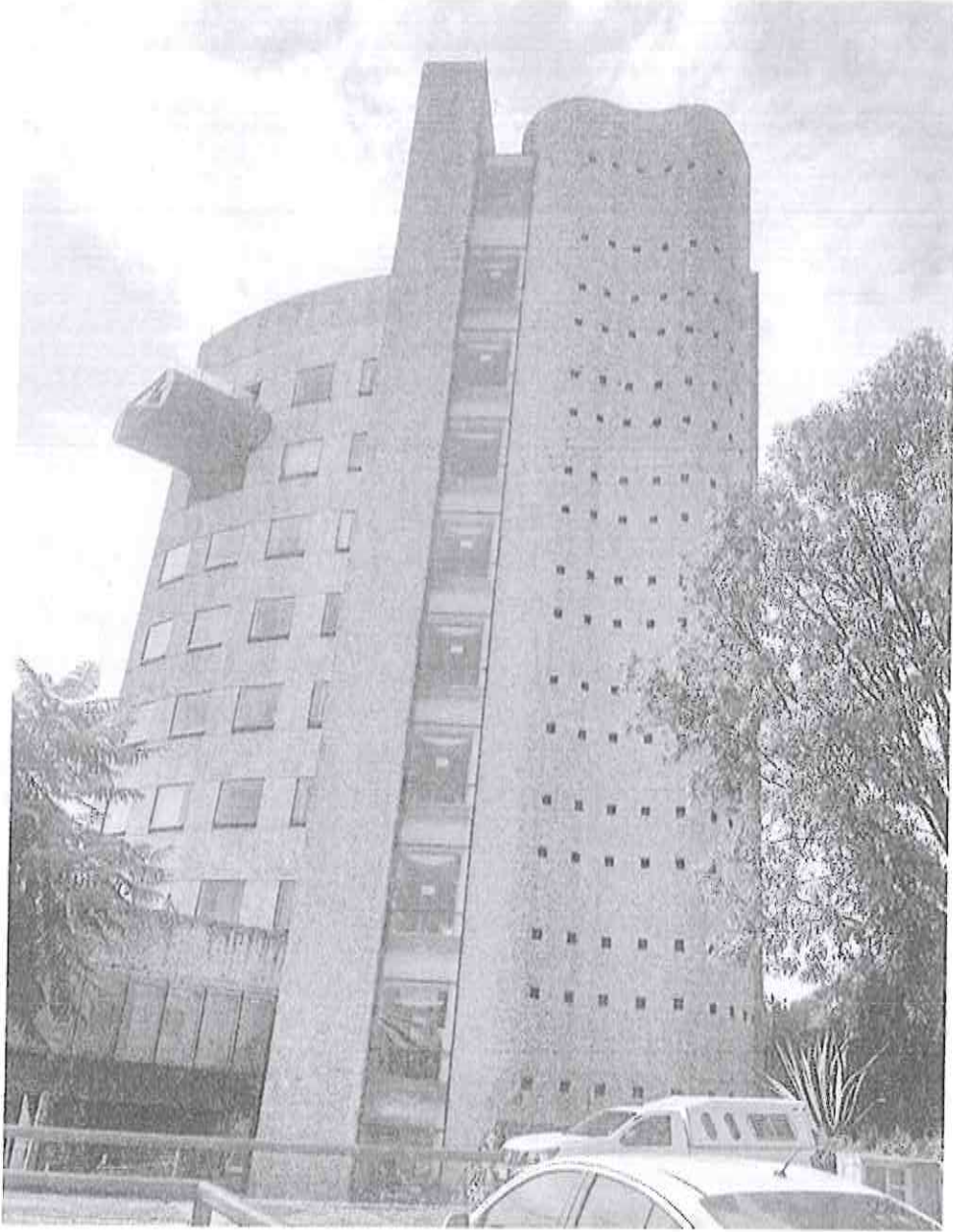
FACHADA POSTERIOR EDIFICIO PRINCIPAL
