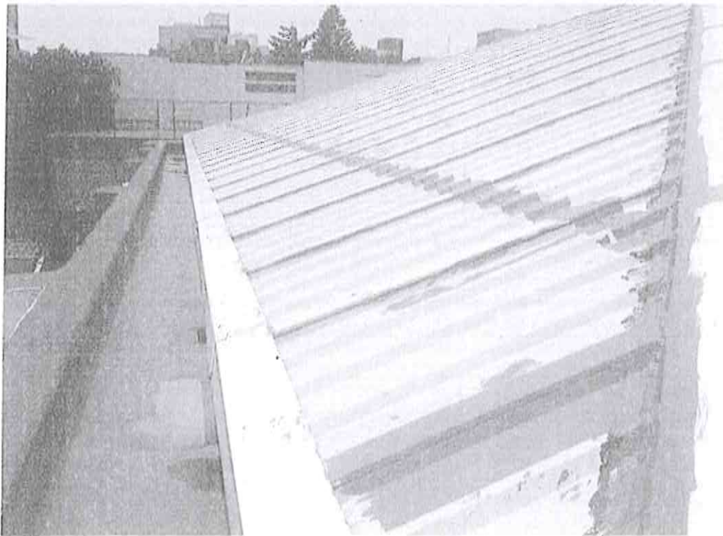
CUBIERTA DE CUERPO 2 ESTRUCTURA METÁLICA Y MULTIPANEL
