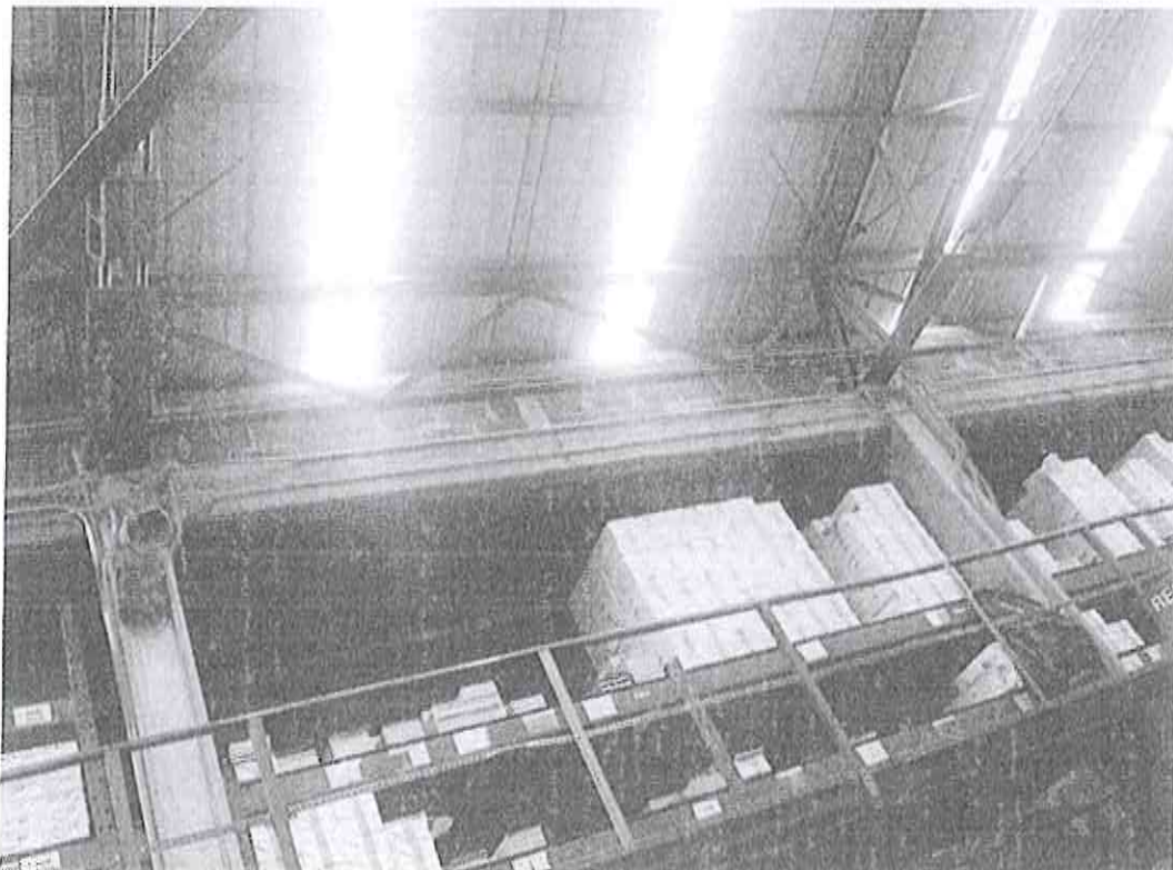
ARMADURAS METÁLICAS APOYADAS SOBRE COLUMNAS DE CONCRETO
