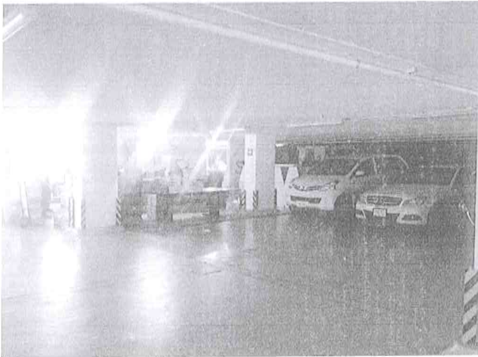
ESTACIONAMIENTO EN LA PLANTA BAJA CON COLUMNAS DE CONCRETO Y LOSA PLANA ALIGERADA
