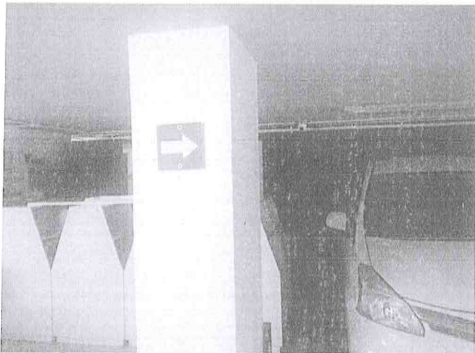
ESTACIONAMIENTO EN LA PLANTA BAJA CON COLUMNAS DE CONCRETO Y LOSA PLANA ALIGERADA
