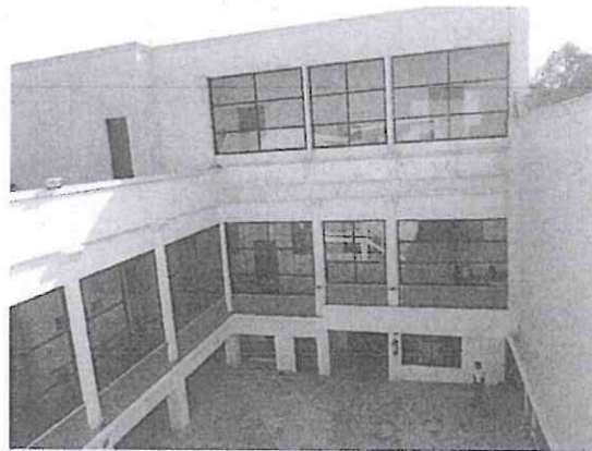
Foto 3. Fachada interior del primer cuerpo en "L" de un nivel, sin afectaciones estructurales.
