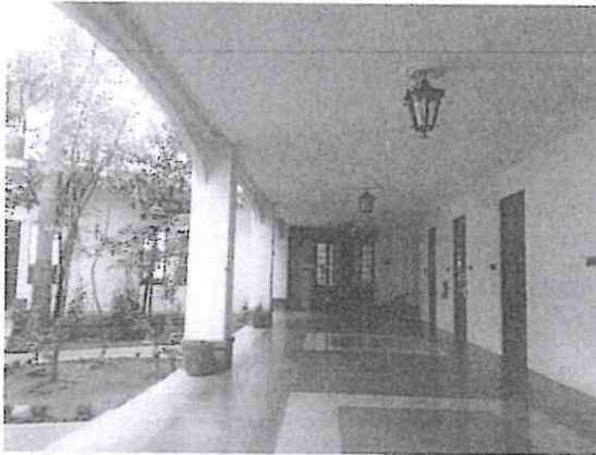
Foto 3. Columnas, arcos, entepiso y firmes del pasillo de la casa hogar para varones, sin afectación estructural.
