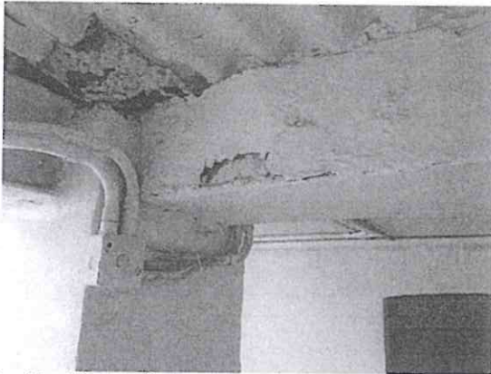
Foto 11. Afectedación por humedad en una esquina del entrepiso del sótano. Se recomienda su reparación. Foto 12. Barda de colindancia, a pesar de su excesiva altura, está en buen estado estructural.
