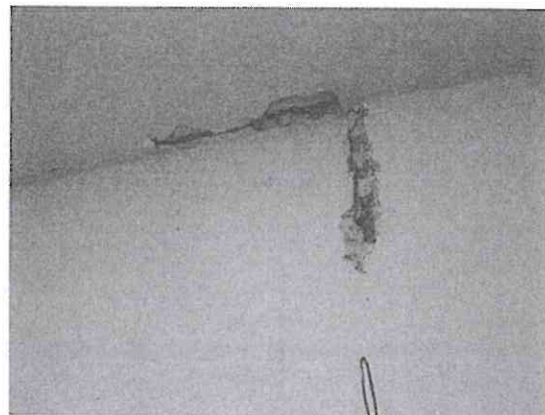
Foto 9. Descubrimiento de columna donde se aprecia que el elemento estructural no presenta la más mínima afectación.
