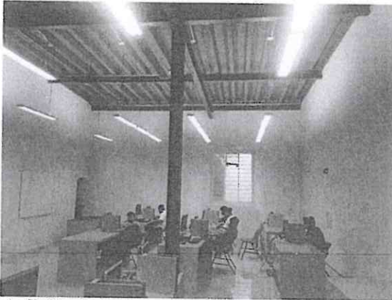
Foto 7. Muros, columna y vigas de madera de la sala de computo de la casa hogar para varones, en buen estado estructural.
