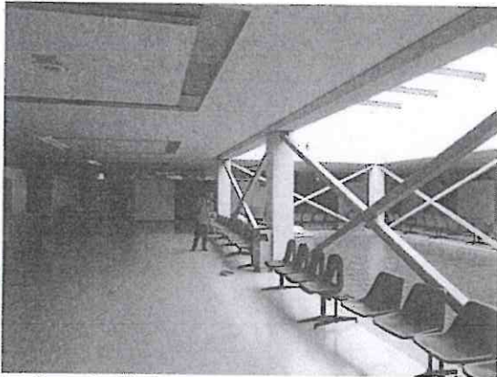
Foto 3 y 4. Refuerzo realizado al inmueble posterior a su construcción original, hecho a base de contraventeos y travesaños de cuerpo a cuerpo de estructura metálica.
