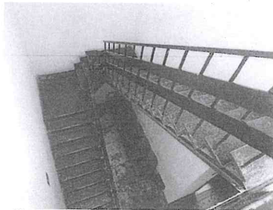
Foto 13. Se observa que en la azotea hay una construcción ajena al edificio original. Se recomienda hacer un análisis de la carga que representa, para evaluar el riesgo estructural que podría representar. Foto 14. Escalera de estructura metálica, en buen estado estructural.
