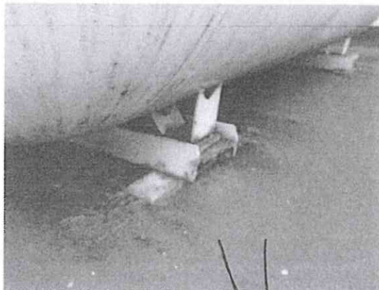
Foto 15 y 16. Tanque de gas ubicado en la zona de acceso de suministros, apoyado sobre una losa inclinada. Se recomienda complementar su fijación con elementos adicionales sujetos al muro. Lo anterior para evitar su probable caída durante algún eventual movimiento sísmico.
