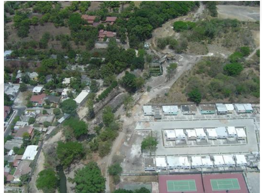
Construcciones en zona federal
