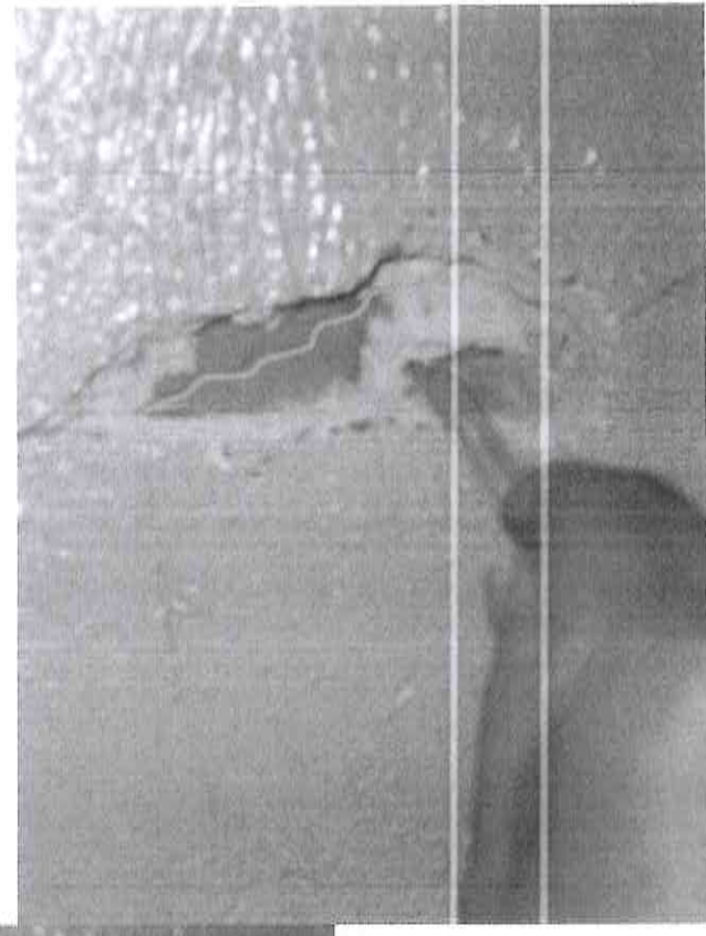
FOTOGRAFIA 15.- Cala realizada en el muro de la fotografía anterior donde se detectó que la fisura si afecto a las piezas de mampostería.
