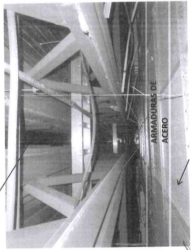
Fotografía 47 y 48.- No se aprecian daños en las columnas y armaduras por efecto del sismo, sin embargo se advierten efectos de oxido en dichos elementos estructurales de severidad baja.
