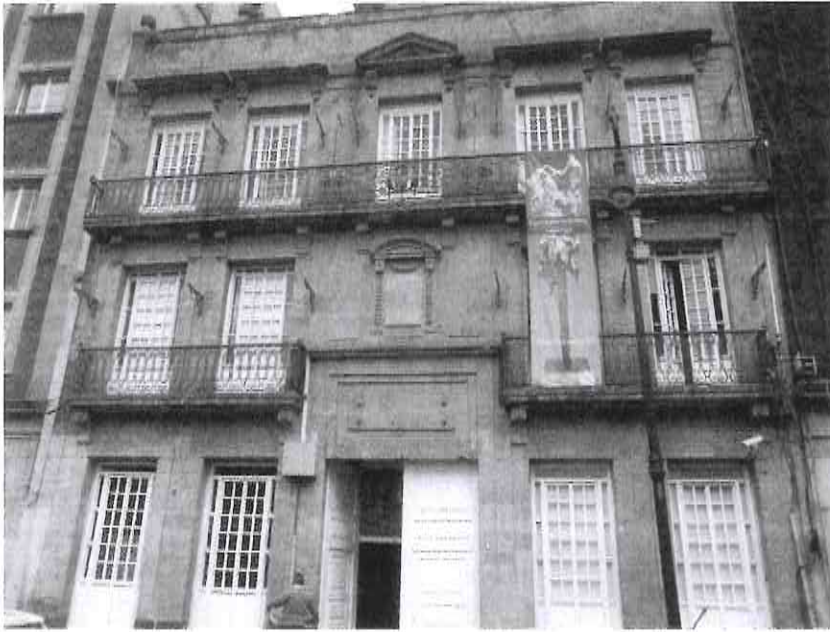
ASPECTO GENERAL DE LA FACHADA DEL EDIFICIO.
