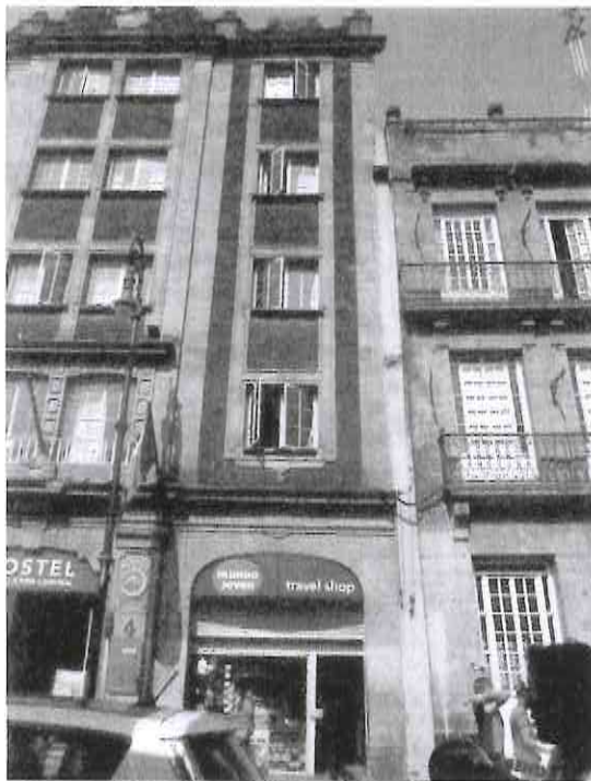
ASPECTO DE LAS JUNTAS CONSTRUCTIVAS ORIENTE Y PONIENTE POR LA FACHADA DE LA EDIFICACION.
