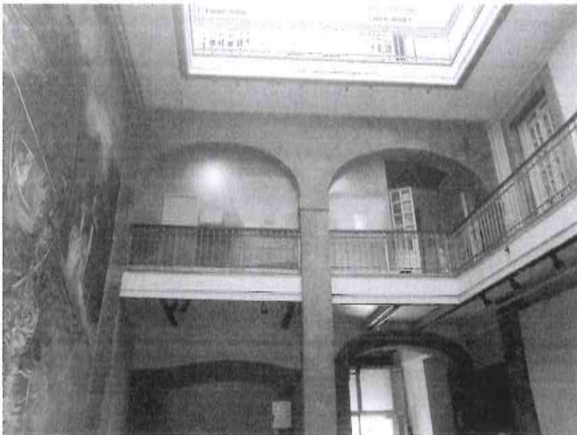
ASPECTO DEL INTERIOR DE LA EDIFICACION, SE MUESTRAN LOS MUROS DE MAMPOSTERIA ASI COMO LOS ARCOS Y COLUMNAS DE CANTERA.
