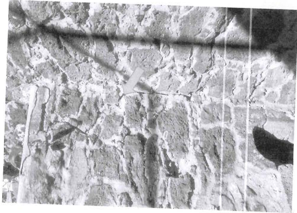
Fotografía 21 y 22.- En el muro de colindancia sur de la capilla hay grietas que es necesario reparar para evitar el deterioro por el ingreso de lluvia. No sabemos si fue consecuencia de los sismos recientes o estaban antes de septiembre ya que para revisar es necesario entrar por la propiedad vecina.
