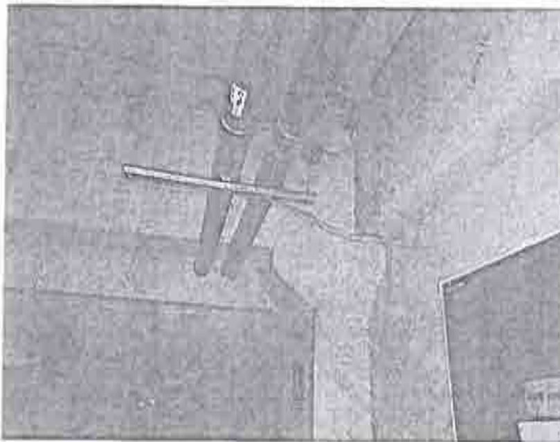
FOTOGRAFIA 4. TRABES CON CAPITEL TIPO DIAMANTE LIBRE FISURAS, SÓTANO.
