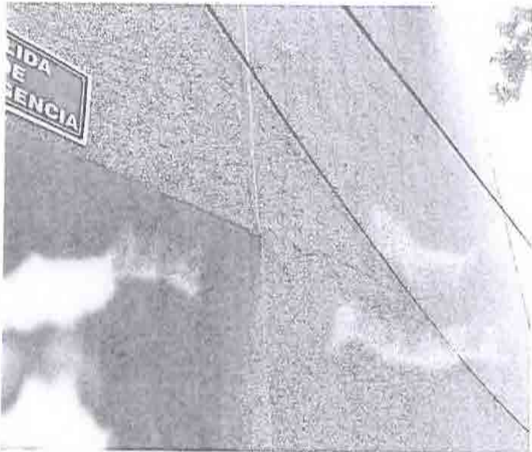
FOTOGRAFÍA: Fachada lateral del edificio B, con una fisura horizontal en el acabado, a la altura del vano de la puerta.
