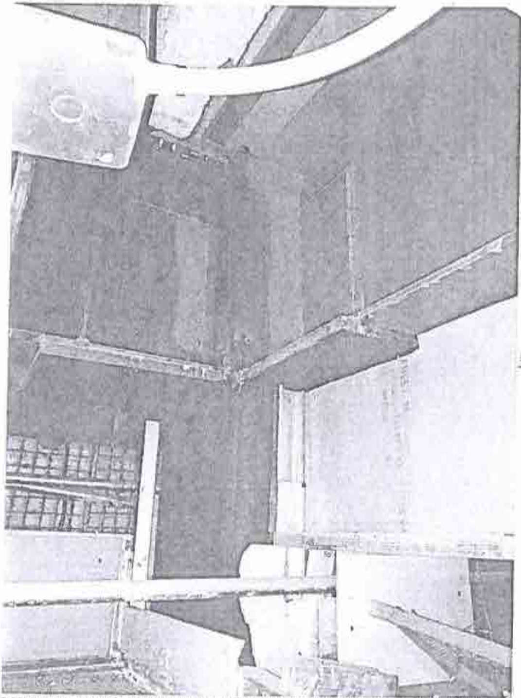
FOTOGRAFIA 10. MUROS DIVISORIOS DE TABLAROCA DESLIGADOS DE LA ESTRUCTURA PRINCIPAL
