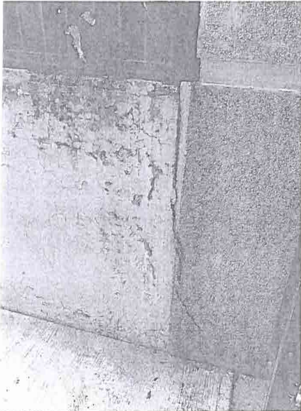
FOTOGRAFIA 14. FISURA VERTICAL EN LA UNION DE COLUMNA Y MURO BAJO, EN LA COLUMNA LA FISURA ES EN EL ACABADO.
