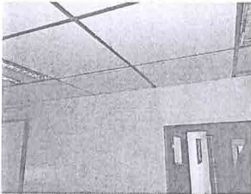
FOTOGRAFIA 12. PLAFÓN TIPO MODULAR EN CONDICIONES SANAS
