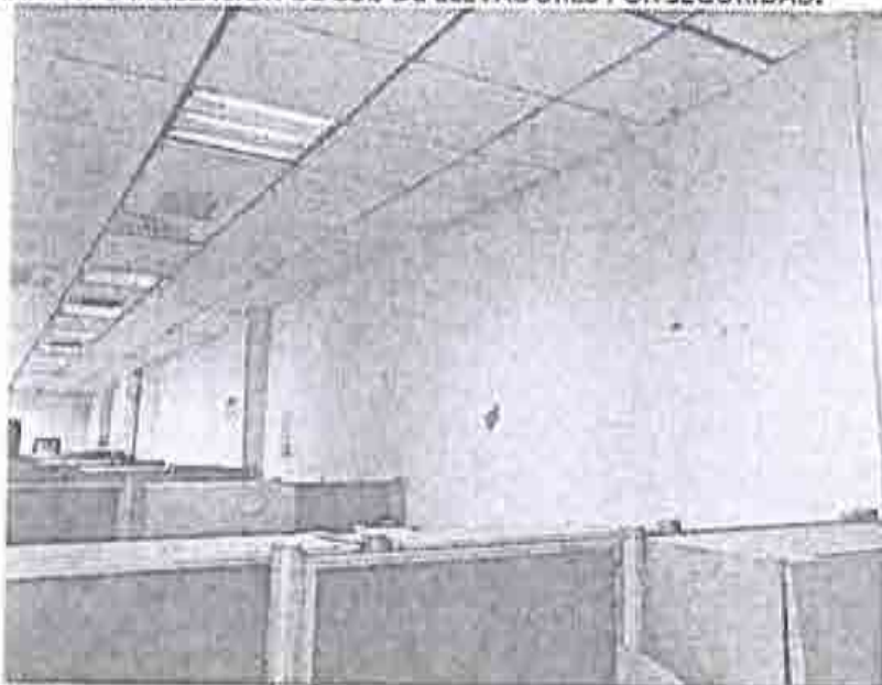
FOTOGRAFIA 21. MURO DIVISORIO DE TABIQUE CON ACABADO CRAQUELADO PRONUNCIADO
