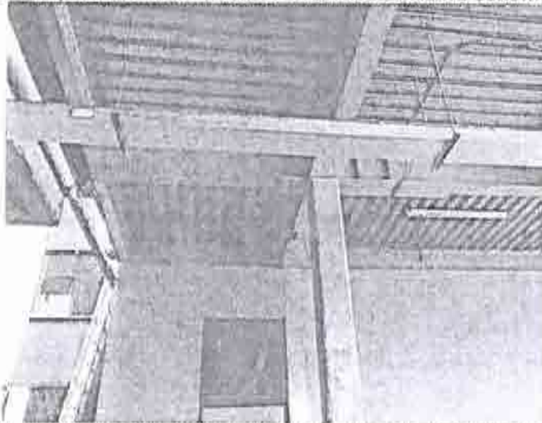
FOTOGRAFIA 15. ANEXO POSTERIOR DEL EDIFICIO B. DE ESTRUCTURA METALICA.
