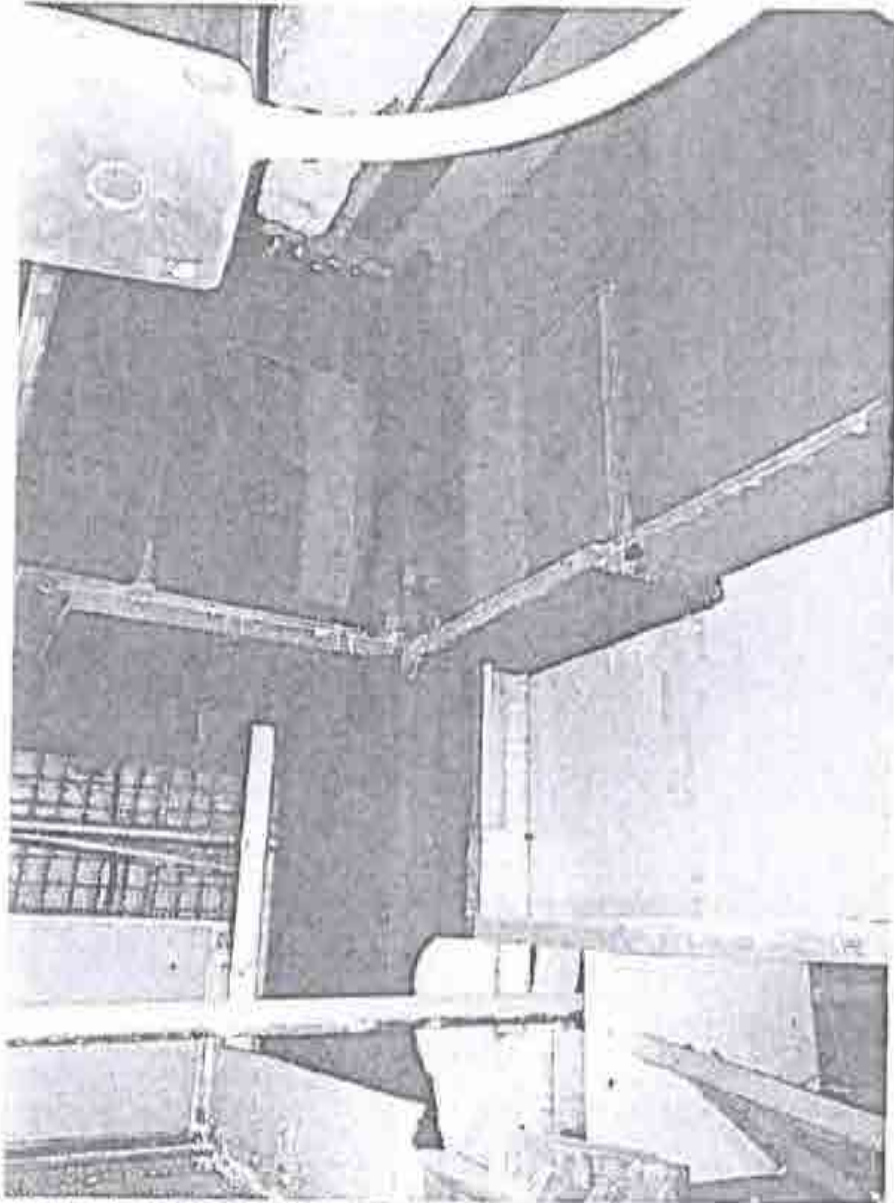
FOTOGRAFIA 3. PLACAS DE MOMENTO Y CORTANTE EN BUEN ESTADO EN CONEXIÓN TRABE COLUMNA
