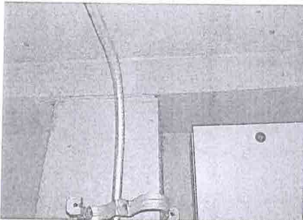
FOTOGRAFIA 12. UNIONN DE COLUMNA Y TRABES DE COLINDANCIA SIN DEFORMACION NI FISURAS, MUROS SIN FISURAS.
