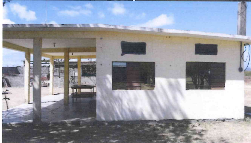
CUARTO DE BATERÍAS
