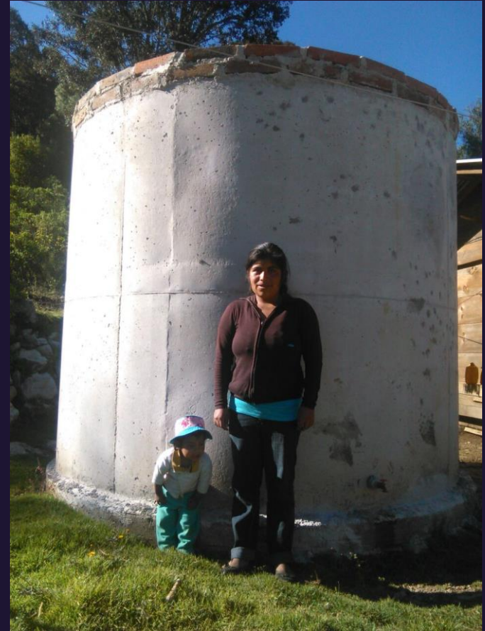
Sistemas de captación de agua
