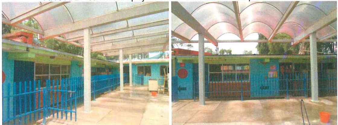
AHORA: Estructura apoyada sobre columnas independientes.
