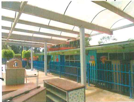
AHORA: Estructura apoyada sobre columnas independientes.
