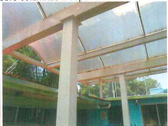
AHORA: Estructura apoyada sobre columnas independientes.
