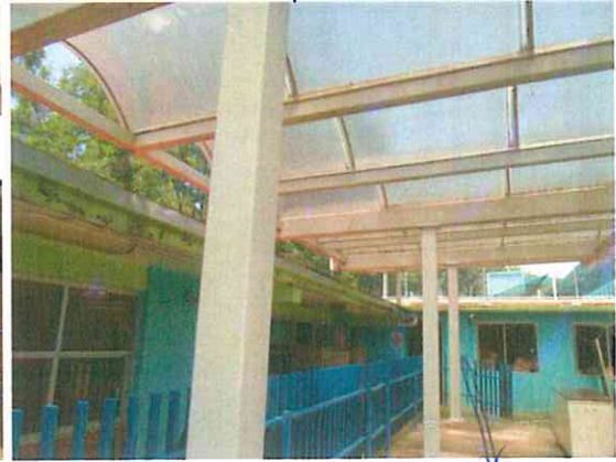
AHORA: Estructura apoyada sobre columnas independientes.
