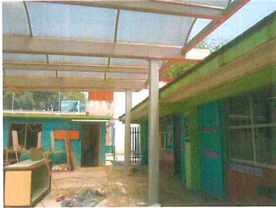
AHORA: Estructura apoyada sobre columnas independientes.
