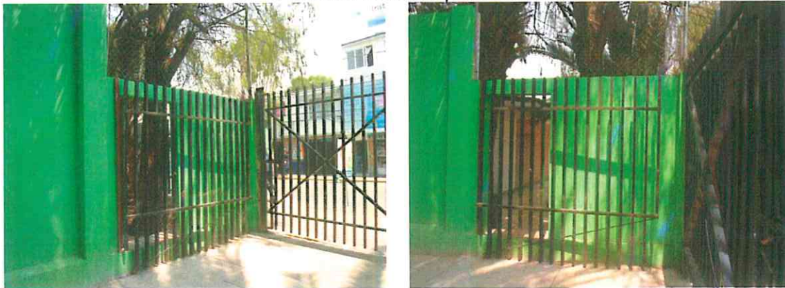
AHORA: Barda reparada.
