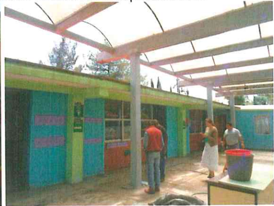
AHORA: Estructura apoyada sobre columnas independientes.
