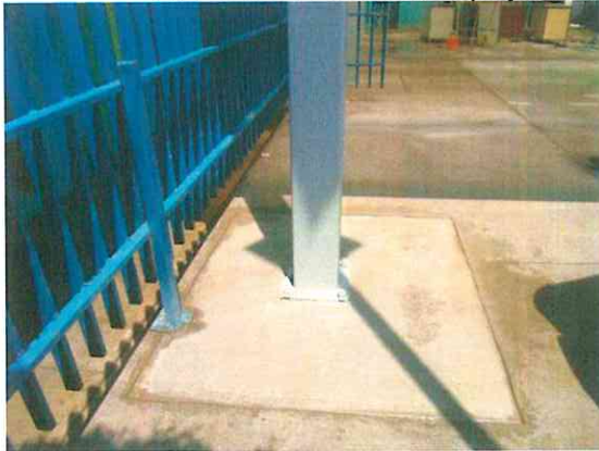
AHORA: Estructura apoyada sobre columnas independientes.
