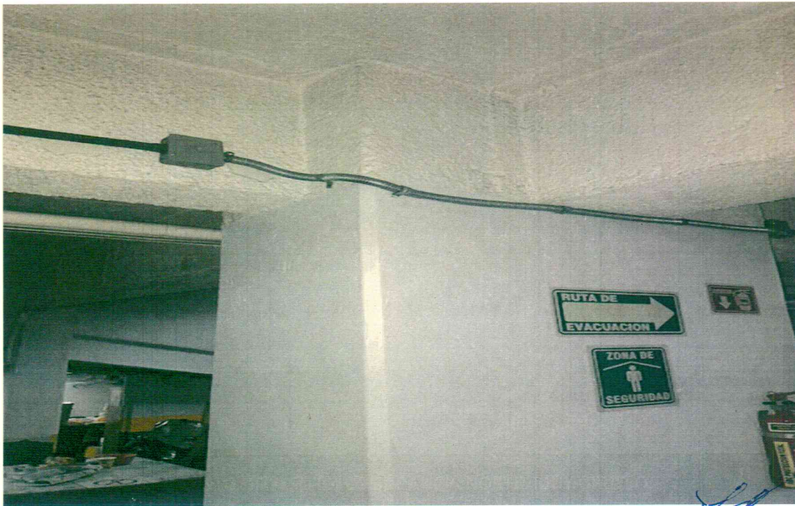
FOTO 4. COLUMNA Y TRABES DE P.B. CON LOSA MACIZA.
