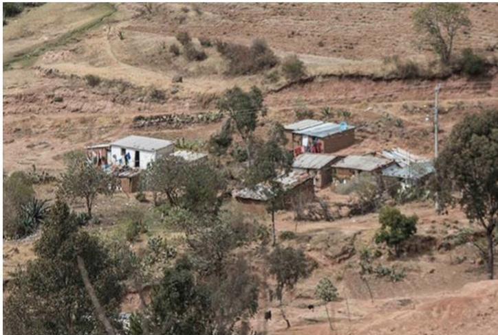
Las condiciones precarias de las viviendas, hacen más vulnerables a los más de 260 habitantes. Foto: Víctor Jiménez
