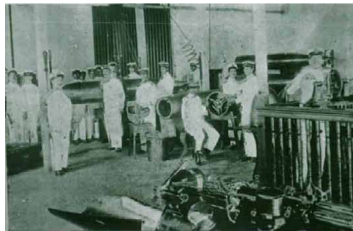
Interior de la Estación de Lanzatorpedos 80
