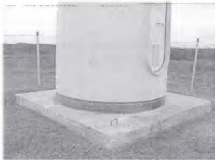
Fig. 6. Área ocupada por la base del aerogenerador 2 de Turiguanó, fundida sobre el suelo formado por roca muy dura.
