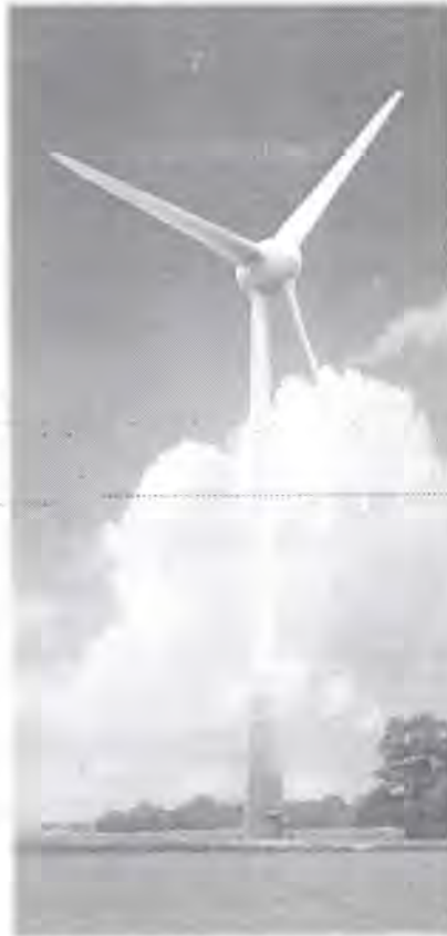
Fig. 5. Degradación de los colores de la torre de un aerogenerador Enercon, que le permite integrarse más con el paisaje, lo que resulta una variante muy atendible.
