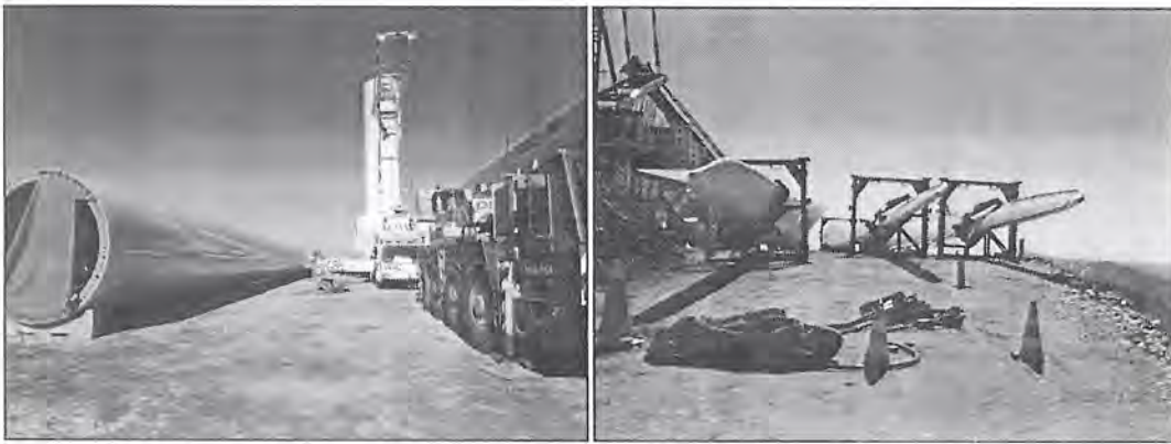
Plataformas de montaje y acopio
