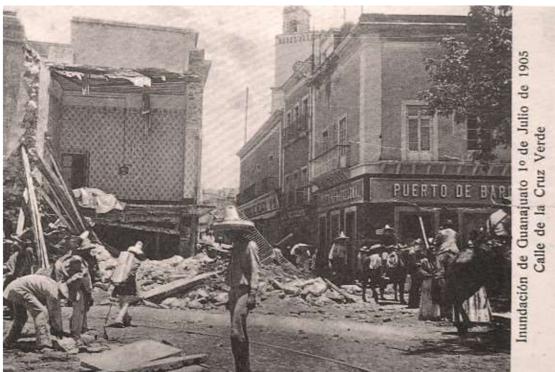
Figura 3-54. Efectos causados por la inundación de julio de 1905.
