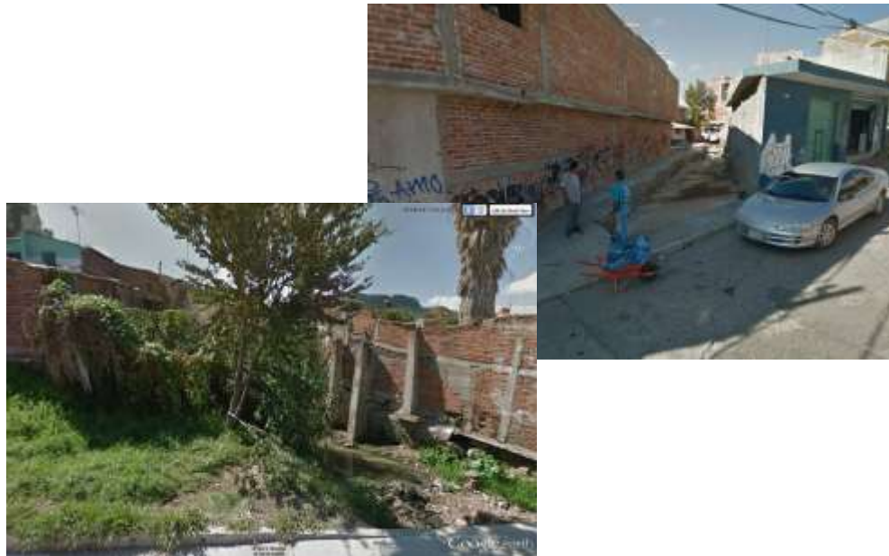
Figura 4-5. Obstrucción y reducción del área hidráulica en arroyo Brinco del diablo, Abasolo.
