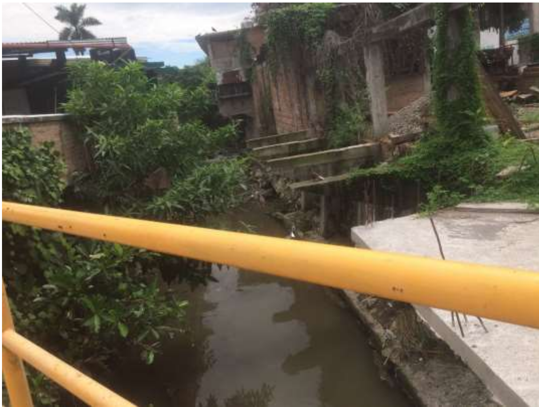
Figura 4-4 Modificación del área hidráulica del cauce por presencia de asentamientos humanos
