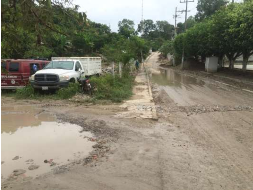
Figura 4-5 Acumulación de tirantes en zonas topográficas bajas.
